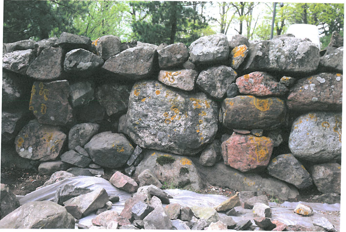
Kuva 7. Muurirakenteen itäpuolen korjaus v. 2010
