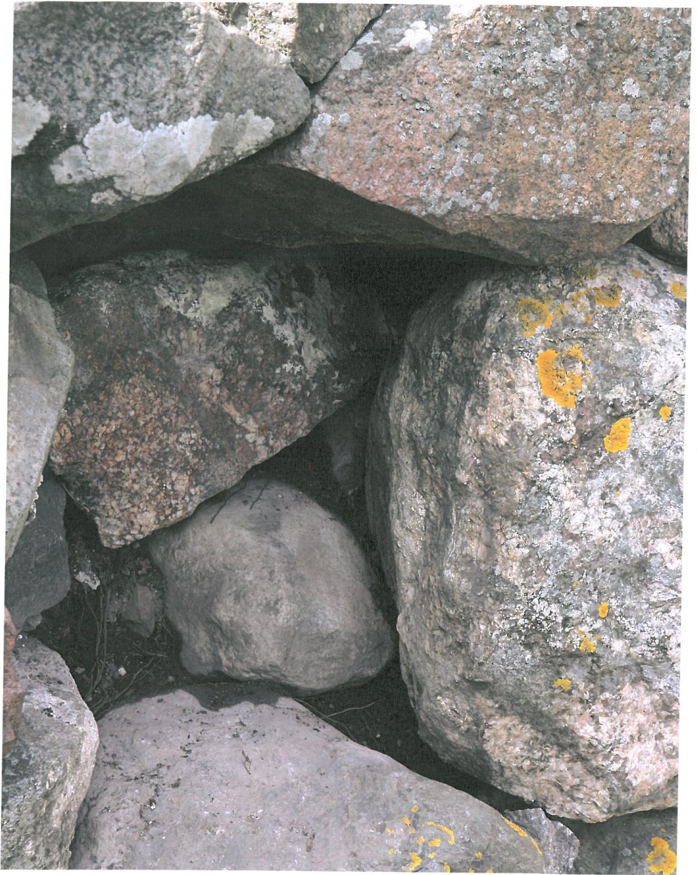
Kuva 9. Muurirakenteen itäpuolen muurin ydinosan rakenne v. 2010
