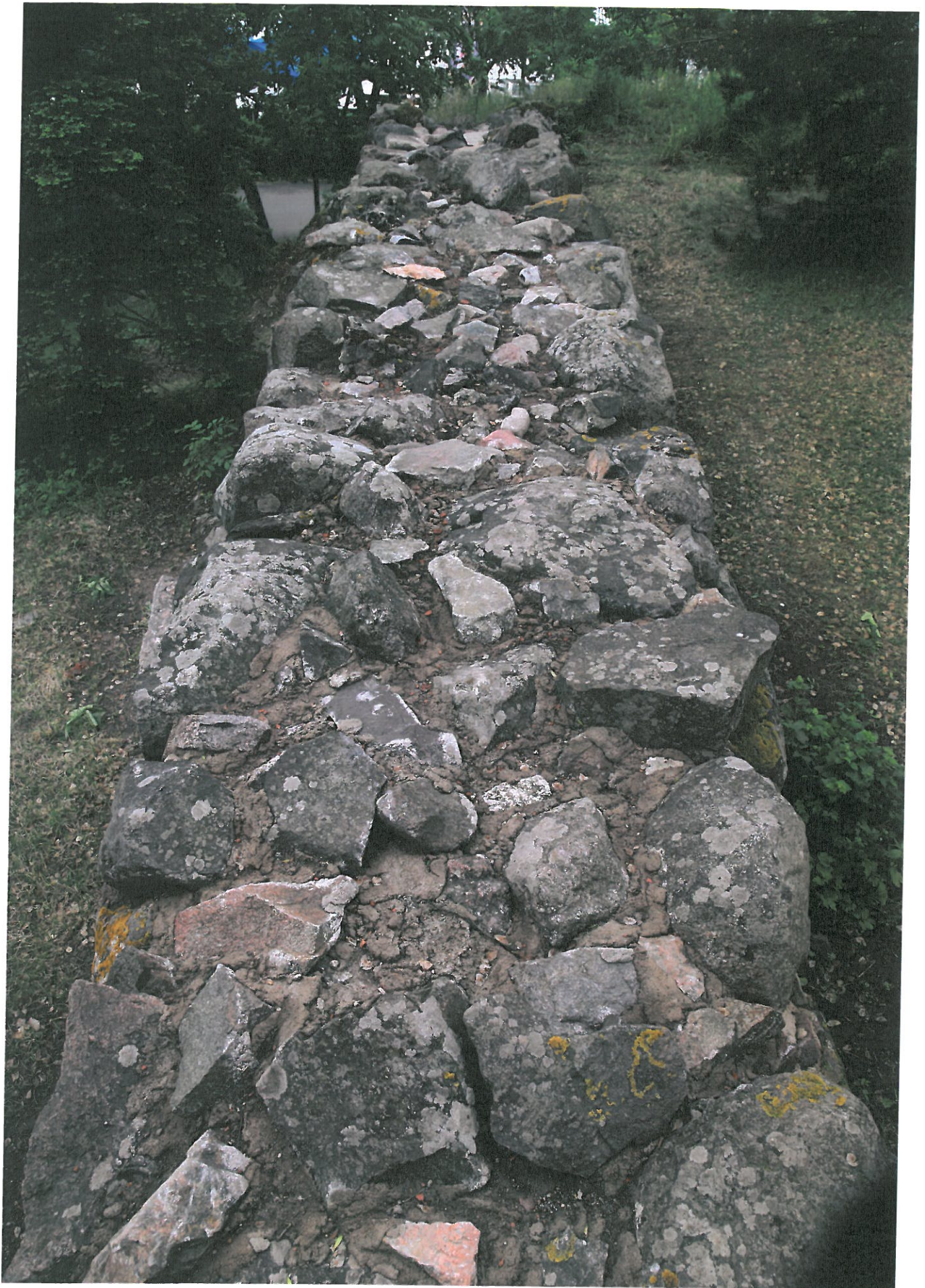
Kuva 11. Muurirakenteen eteläosa päältä nähtynä valmiina 2010
