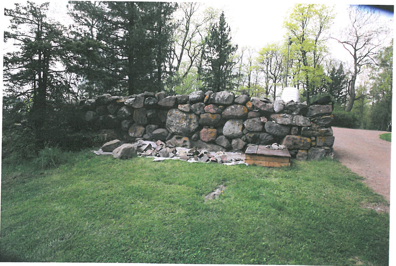
Kuva 5. Muurirakenteen itäpuolen korjaus v. 2010
