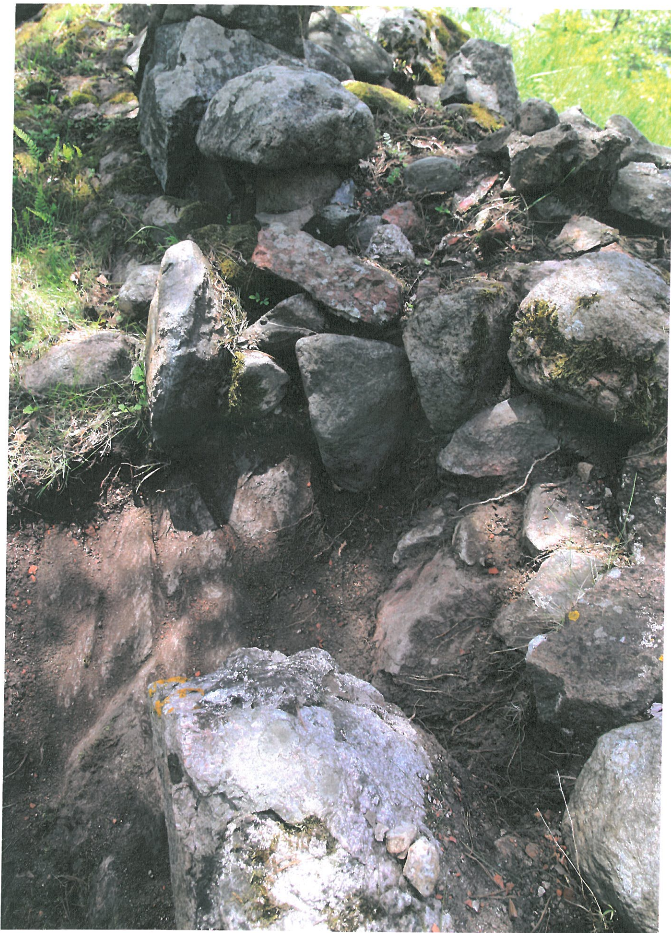
Kuva 10. Muurirakenteen eteläosa päältä nähtynä v. 2010
