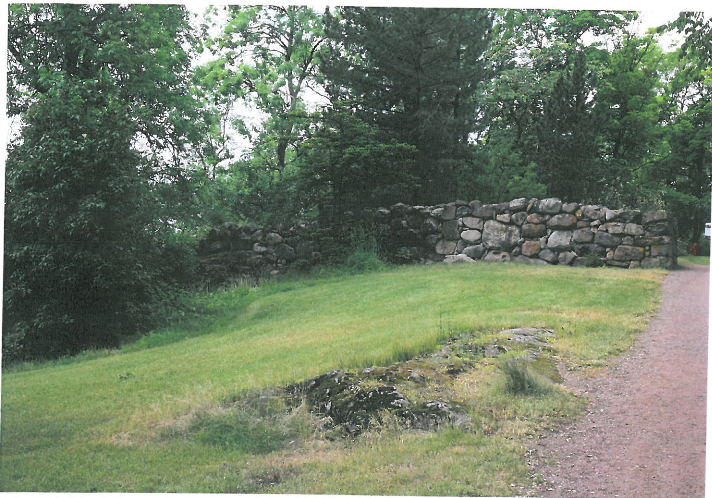
Kuva 14. Muurirakenteen itäpuoli valmiina vuonna 2010.
