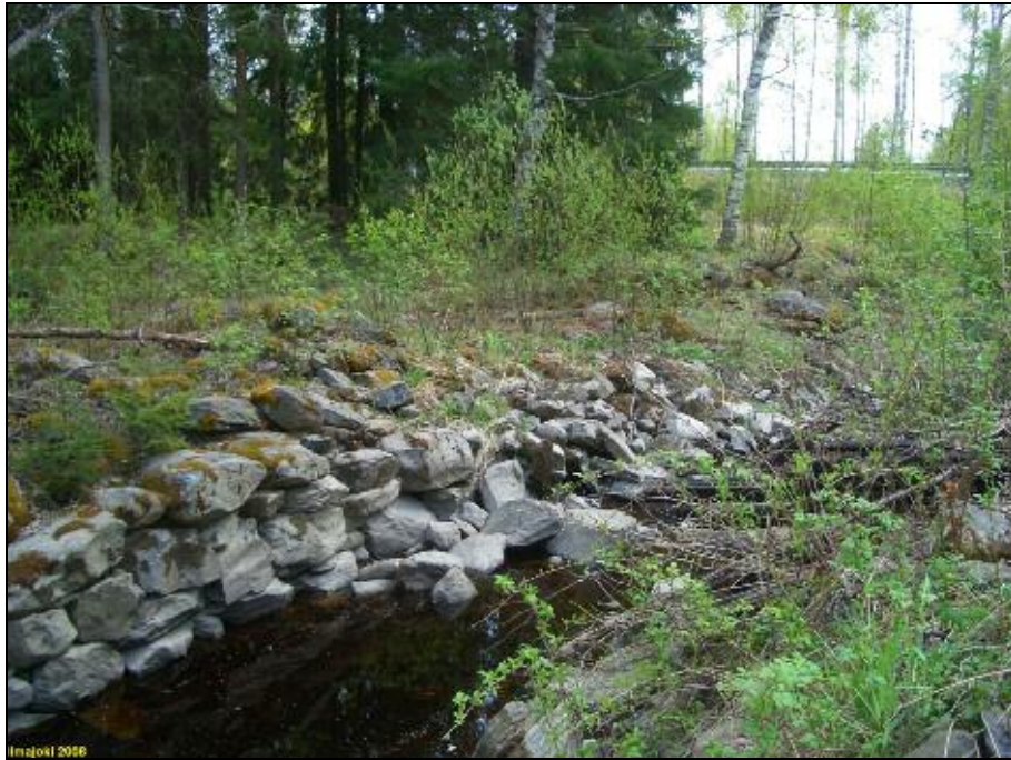
Vanhan uoman rakenteita. taustalla oik. Rengonkyläntie.
