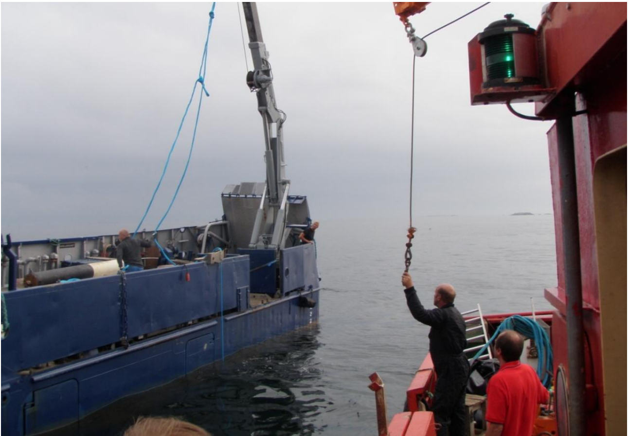
Kuva 3.3. Uuden kiinnittymispoijun asennustyöt käynnissä. Kuva Rami Kokko, Museovirasto (MA201018:1).
