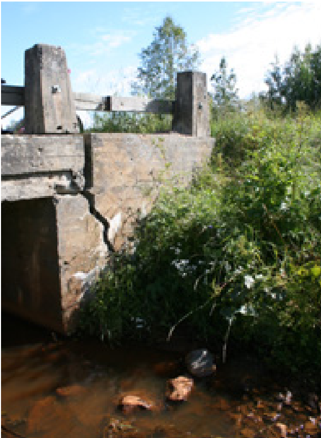
Vanhaa tienpohjaa ja maantiesilta Kemissä Golfkentän eteläpäässä
