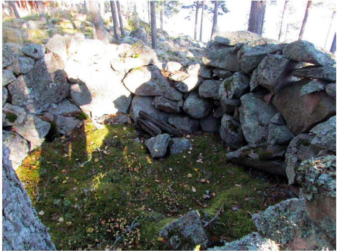
Kuva 43. Kuvan 42 konekivääri/tähystysasema kuvattuna sisäpuolta. Hyvin säilyneiden kivimuurien sisäpuolella oli ampuma-aukon/tähystysaukon kohdalla puujäänteitä. (Taipalsaari, Kattelussaaren – Jänkäsalon osayleiskaava-alueen arkeologinen inventointi 2012:32)
