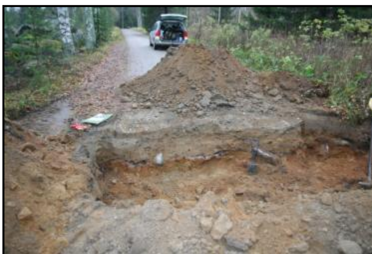
Kaivausalue työn alla (Pohjoiseen)
