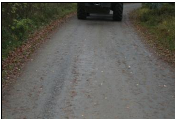
Kaivausalue ennen kaivamista (Pohjoiseen)
