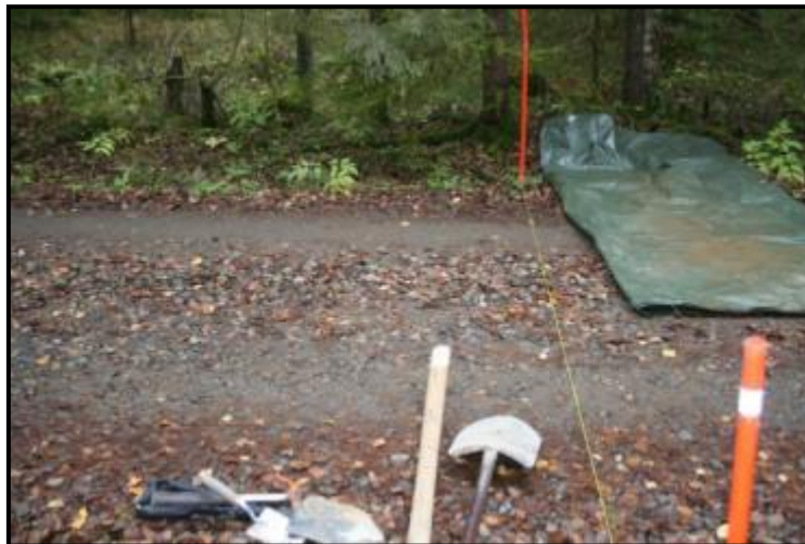
Kaivausalue ennen kaivamista (Länteen)
