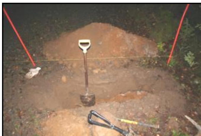
Kaivausalueen työn alla (Etelään)
