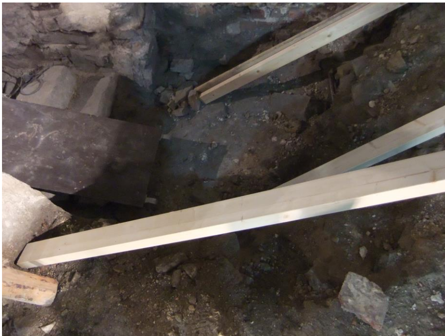
Kuva 13. Alhaalla lattiakiveys R010. I. Aalto. DG2925:115.
