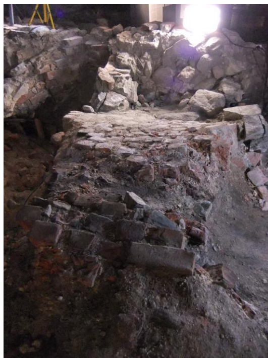
Kuva 6. Holvi R26 kaakkoon ennen purkamista. I. Aalto. DG2925:36
