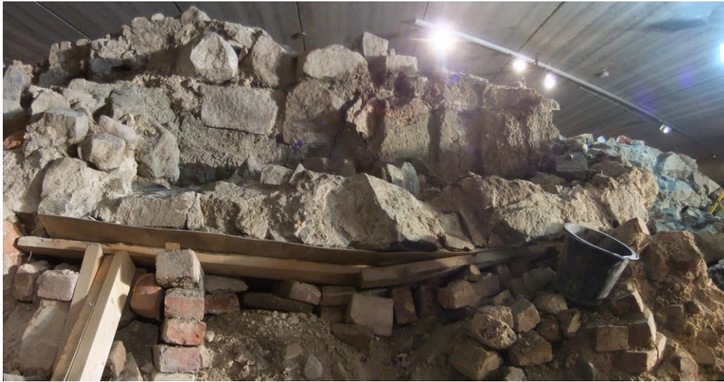
Kuva 12. Holvinjalka R19 kaakkoon. Panoraama. I. Aalto. DG2925:107.
