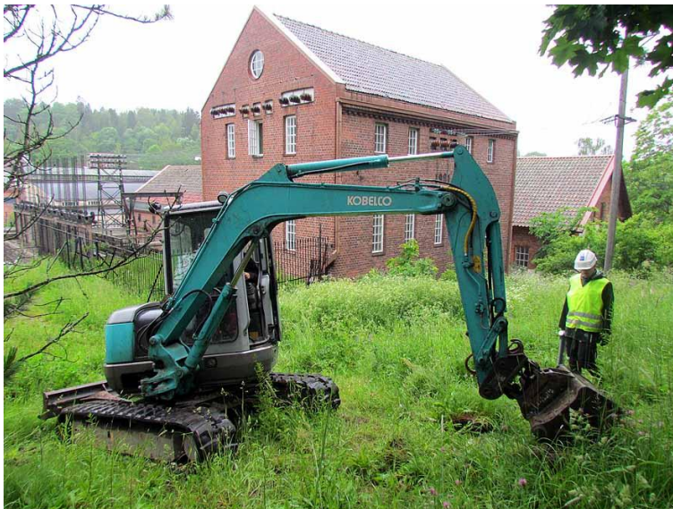
Kuva 2. Kopat kaivettiin koneellisesti arkeologin ja ympäristösuunnittelijan valvonnassa.
