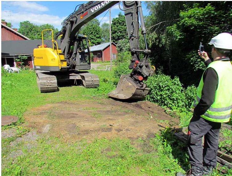
Kuva 4. Näytteenoton ja havainnoin jälkeen koekuopat peitettiin ja niiden -sijainti mitattiin GPS laitteella. Kuva: Kalle Luoto 25.6.2012.
