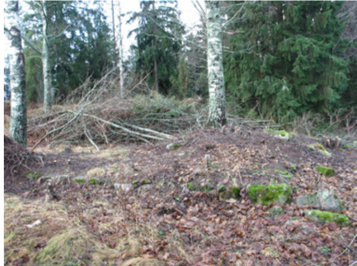
Kuva 8. Päärakennuksen kivijalka, länsipääty.
