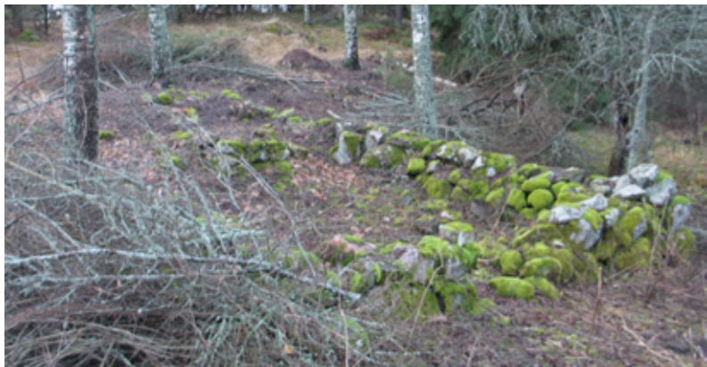
Kuva 7. Aliksen päärakennuksen kivijalan itäpääty.
