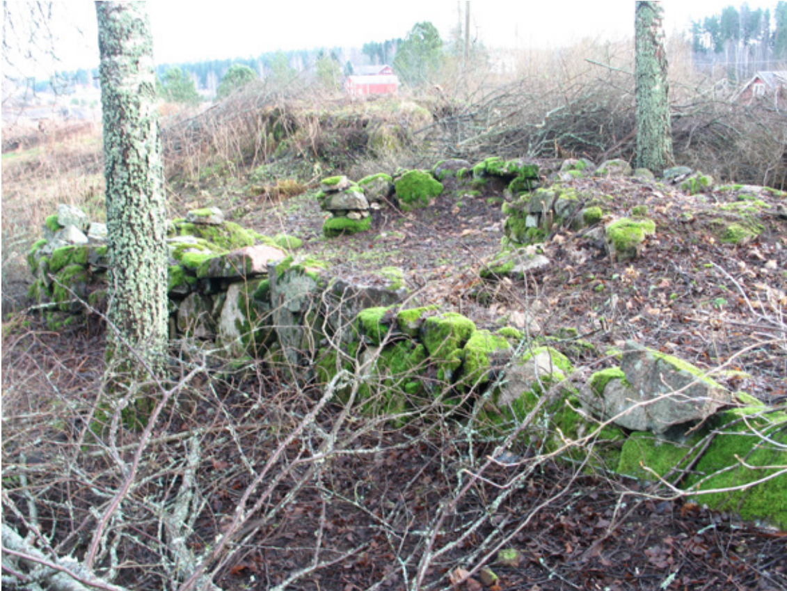
Kuva 4. Aliksen päärakennuksen kivijalka
