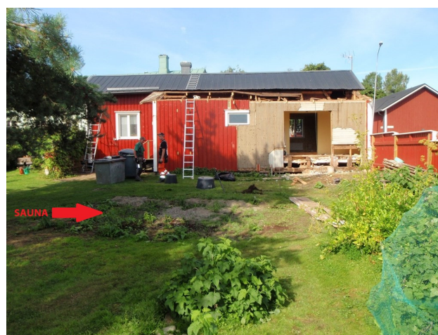
Pihamaa länteen kohti rakennuspaikkaa, edustalta on purettu sauna.
