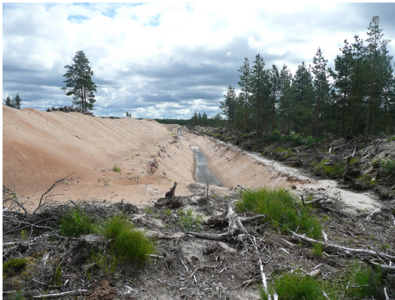
Kuva 4. Kohteen eteläpuolelle rämeen reunalle kaivettu kuivatusoja.
