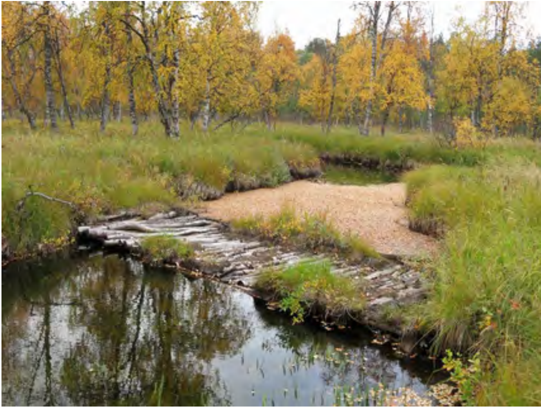
Kuva 347. Harrijärvi. Silta 3. Kuvattu pohjoisesta.
