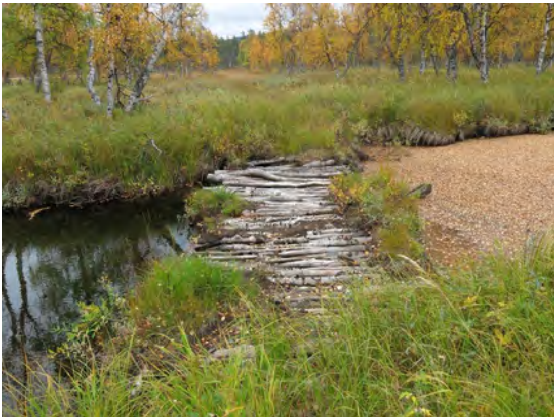
Kuva 348. Harrijärvi. Silta 3. Kuvattu luoteesta.
