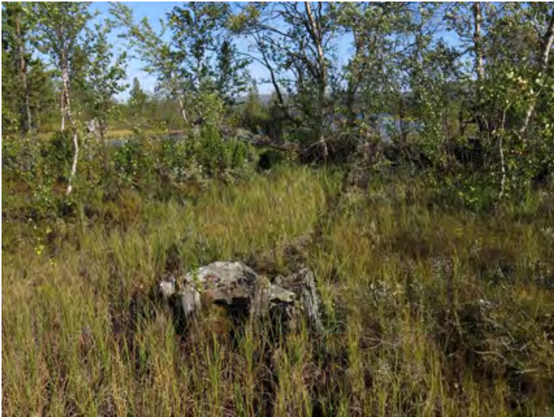
Kuva 372. Luirojärven uittopato. Padon viistotuen alapään tukirakenteita soisella ranta-alueella joen itäpuolella. Kuvattu etelälounaasta.
