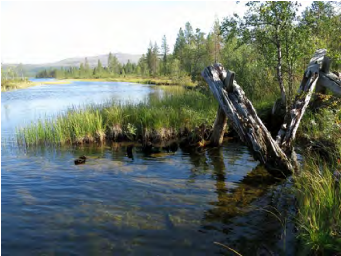
Kuva 366. Luirojärven uittopato. Padon rakenteita joen itärannalla. Taustalla Luirojärven luusua. Kuvattu lounaasta.
