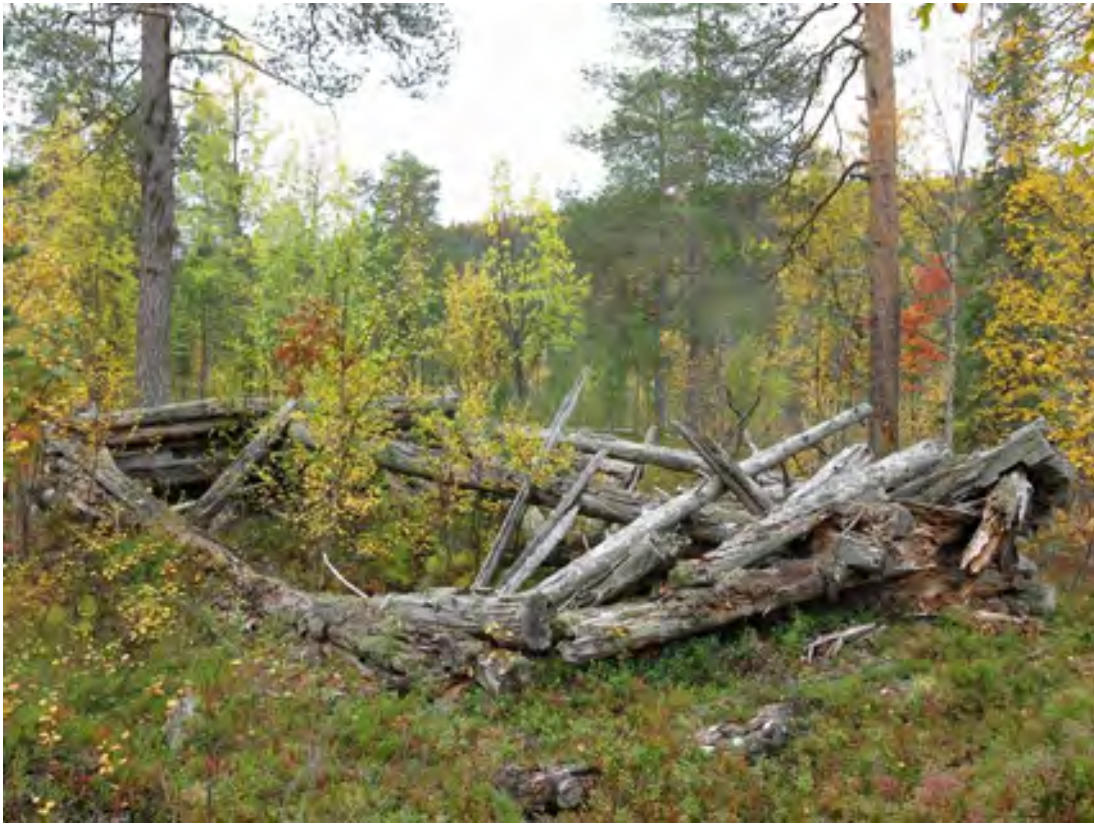
Kuva 351. Kiertämöpään kämppä. Tallin raunio. Kuvattu koillisesta.
