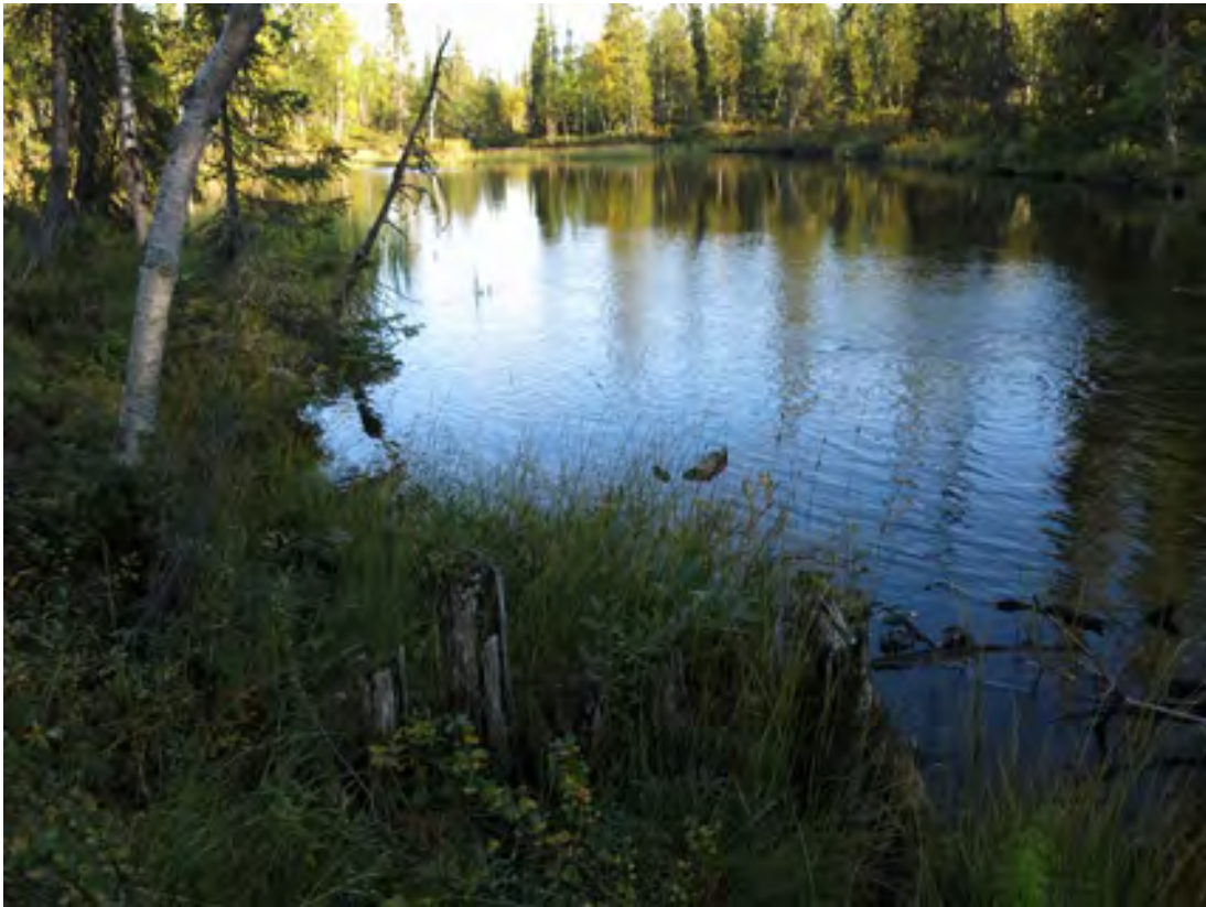
Kuva 358. Kopsusjärven uittopato. Padon viistotukien tukipaaluksia jokeen koillisrannalla. Taustalla Kopsusjokea. Kuvattu luoteesta.
