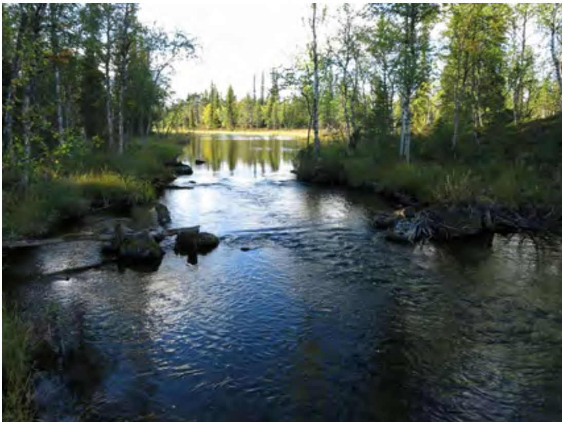
Kuva 361. Kopsusjärven uittopato. Padon tukirakenteita alavirran suunnalta nähtyinä. Taustalla maisemaa Kopsusjärven luusuaan päin. Kuvattu kaakosta.
