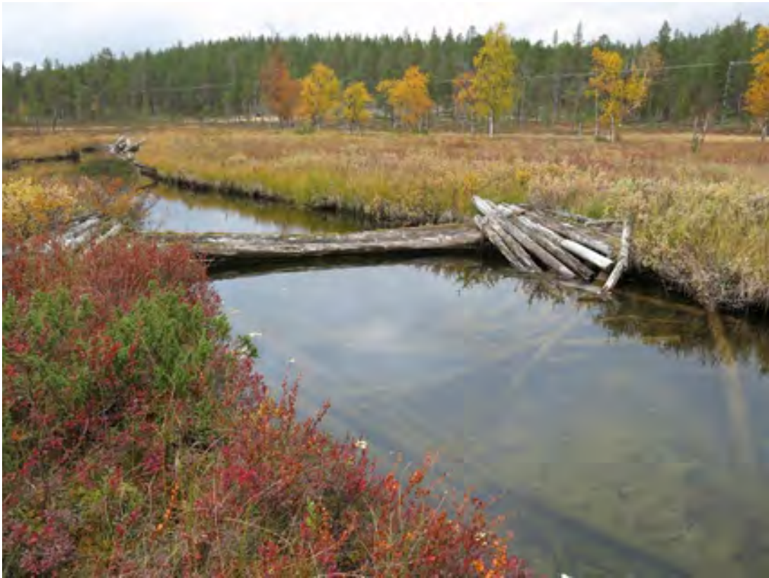
Kuva 343. Harrijärvi. Silta 2. Kuvattu eteläkaakosta.
