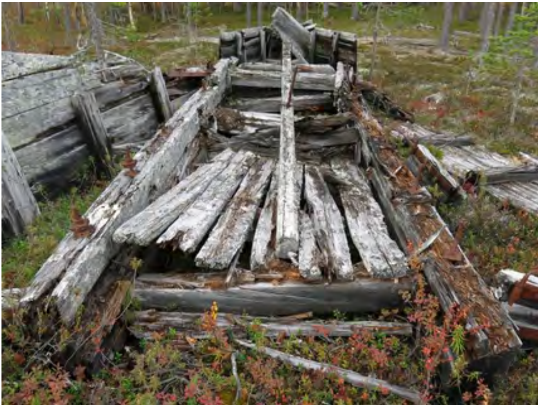
Kuva 350. Aurajängän savottajäännökset. Tukkitien auran jäännös. Jalasten välissä on lankuista rakennettu lava. Kuvattu itäkoillisesta.
