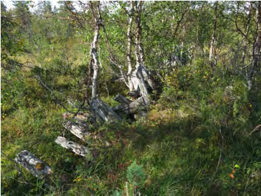
Kuva 368. Luirojärven uittopato. Patovallia ja vallin lounaispuolen tukipaalutusta padon itäpäässä. Kuvattu idästä.
