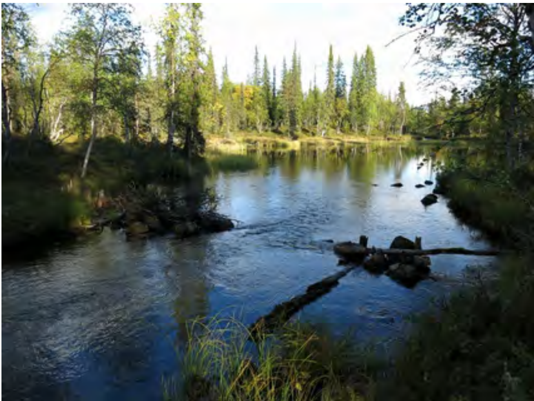
Kuva 359. Kopsusjärven uittopato. Padon tukirakenteita. Jokeen on kasattu kaksi vankkaa kivilatomusta tukemaan padon viistotukia. Kuvattu lännestä.
