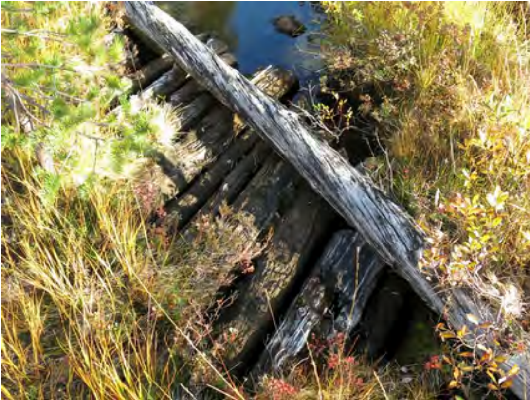
Kuva 343. Aurajängän savottajäännökset. Kolmokkiojan pohjoisempi silta. Lähikuva sillan koillislaidan rakenteista. Kuvattu etelästä.
