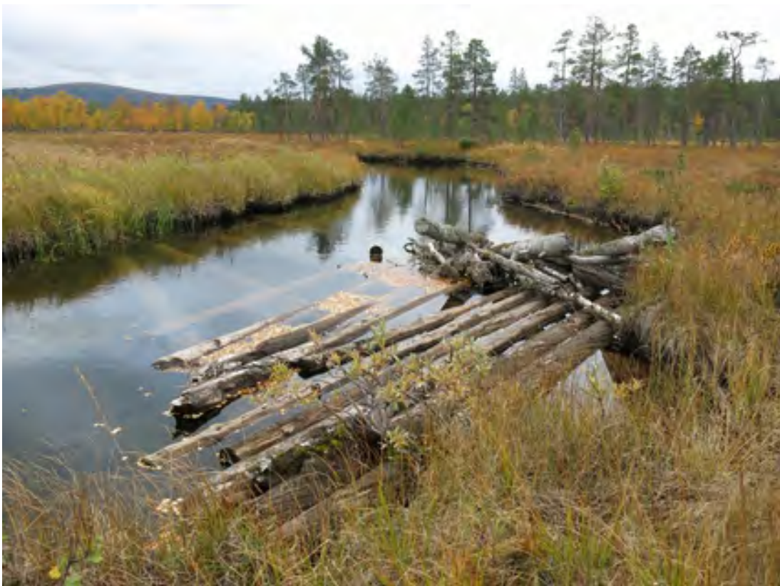
Kuva 342. Harrijärvi. Silta 1. Kuvattu luoteesta.
