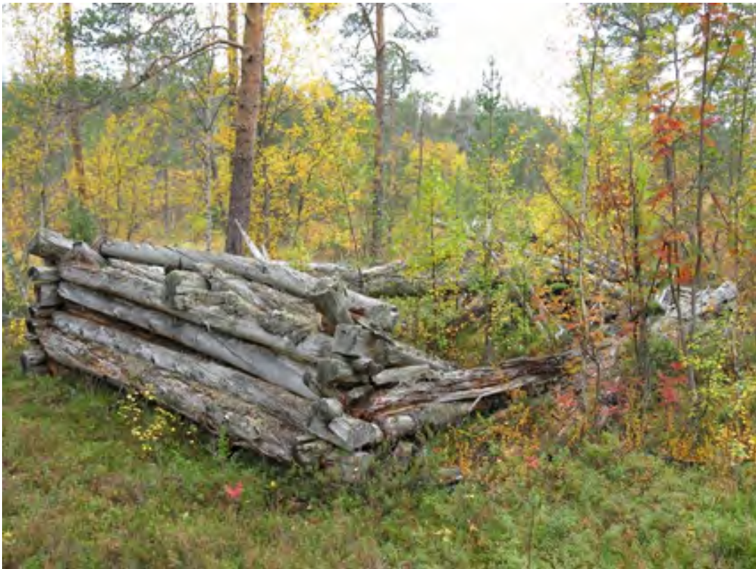
Kuva 352. Kiertämöpään kämppä. Tallin raunio. Kuvattu kaakosta.
