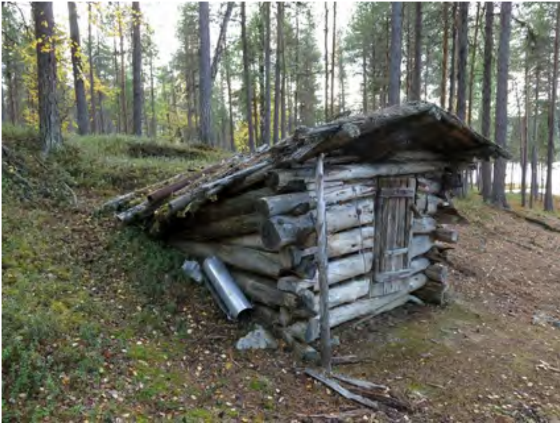
Kuva 394. Pennasen kämppä. Kämpän raunio. Kuvattu pohjoiskoillisesta.
