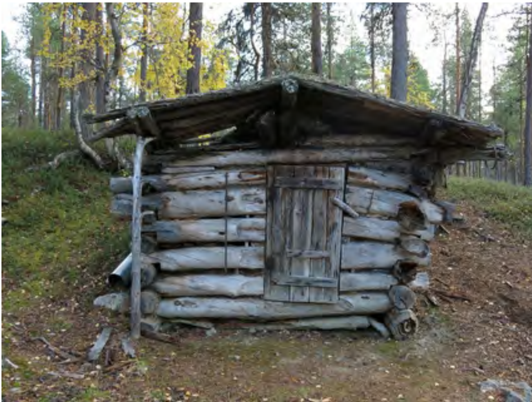
Kuva 395. Pennasen kämppä. Kämpän raunio. Kuvattu pohjoisluoteesta.
