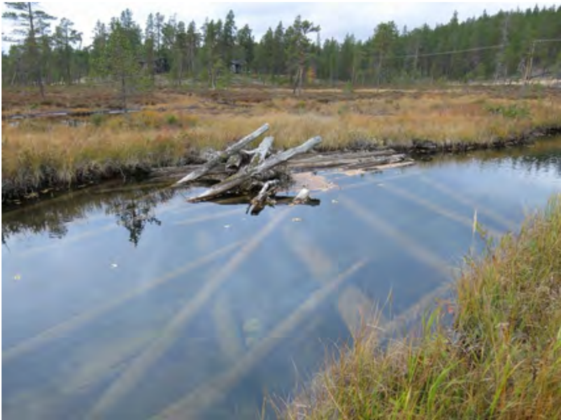
Kuva 340. Harrijärvi. Silta 1. Kuvattu kaakosta.
