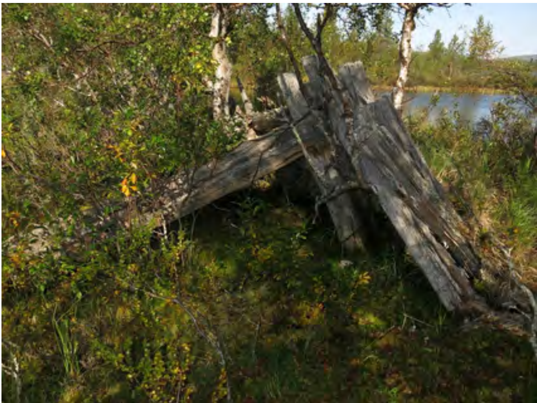
Kuva 369. Luirojärven uittopato. Patovallin lounaispuolen tukipaalutusta padon itäpäässä. Kuvattu kaakosta.
