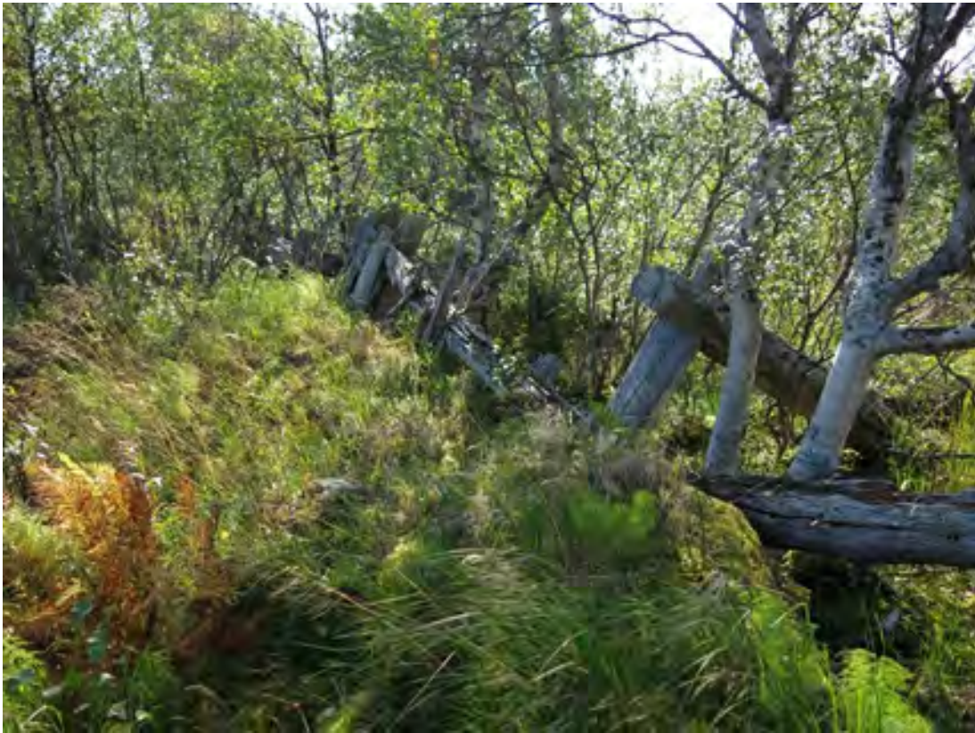
Kuva 370. Luirojärven uittopato. Patovallia ja vallin lounaispuolen tukipaaluista lähellä joen itärantaa. Kuvattu luoteesta.
