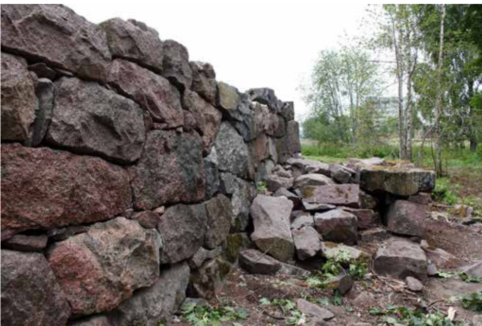
Kuva 71: Muuri 2, länsiosa. Levennysosan länsipuolella oleva kiviladelma. N.
