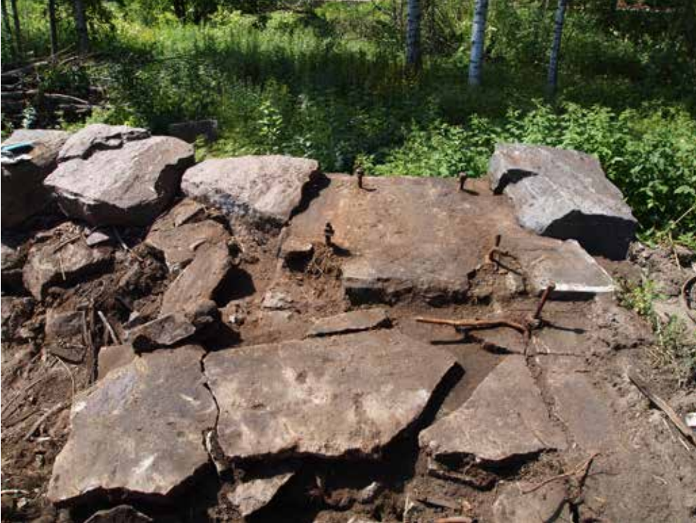
Kuva 70: Muuri 2, länsiosa. Levennysosan puurakenteen alla oleva betonitaso ja kiinnityspultit. E.
