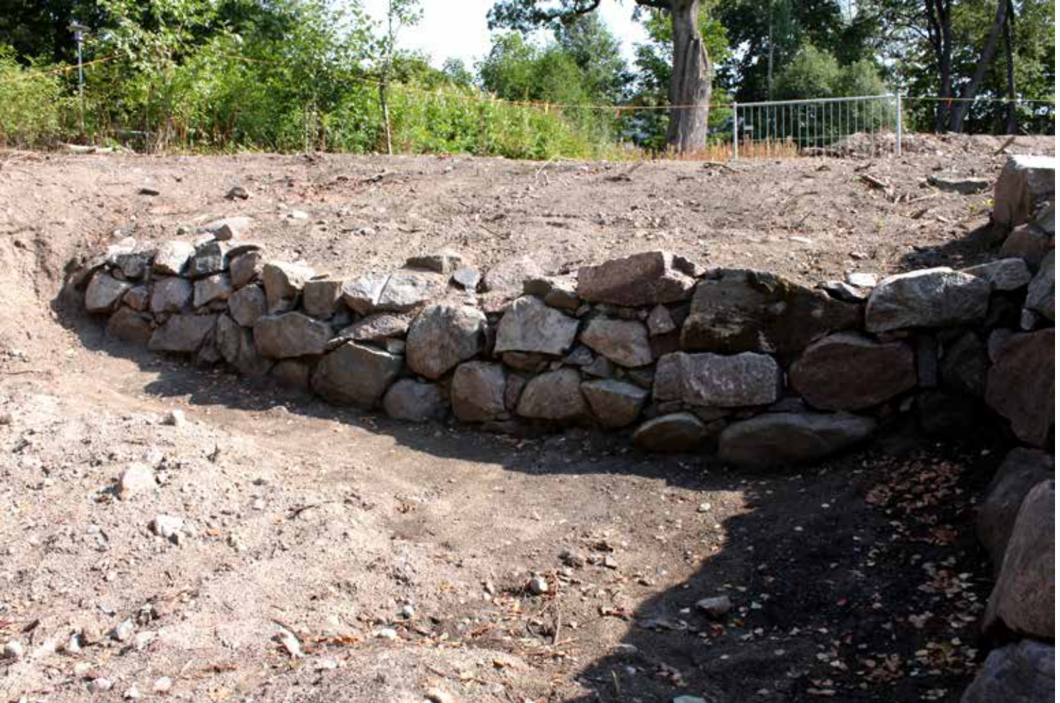
Kuva 75: Muuri 2, luoteisosa. Muurirakenne korjattuna. W.
