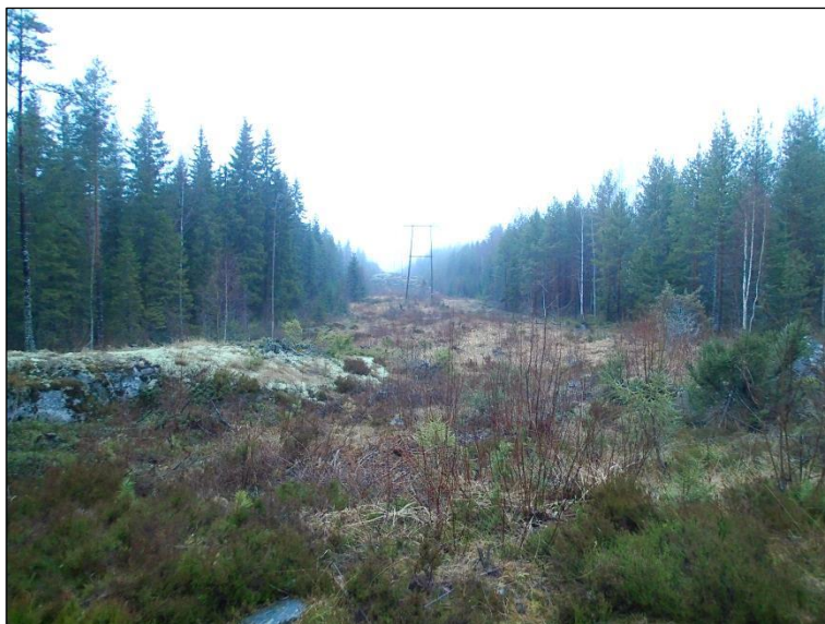
Voimajohtolinjaa, linjan keskivaiheilla
