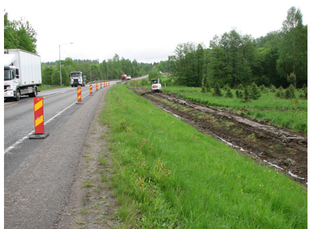
VH2842:K0040746. Työkuva. Kaivinkone peittää aluetta 3. Suunta S-N. 27.5.2010. Kuva U.R
