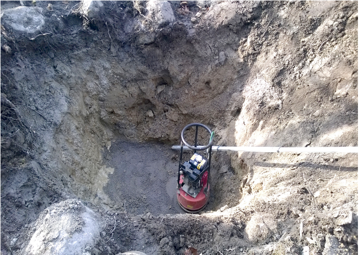
Kuva 3. Perustuskaivanto pohjaan kaivettuna. Pohjalla ohut täyttösepeli. NE. KU 13.3.2014.
