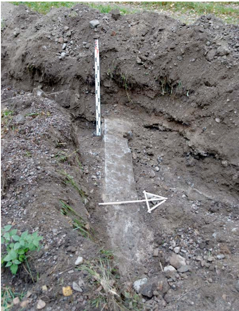
Kuva 6. Rakennuksen perustuskivi kaivannossa 4. Kivi oli navetan lounaispäädyssä 20,65 m etäisyydellä. Nuoli osoittaa koilliseen. AKDG3322_039
