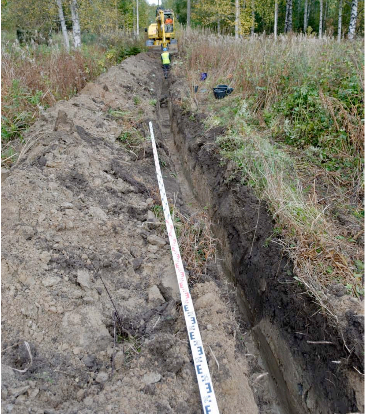
Kuva 2. Kaivanto 2:n N-seinämää noin 5–10 metrin kohdalla. Multasavella täytetty kaivanto n. 5,5–8 metrin kohdalla. Kuvattu kaakosta. AKDG3322_008
