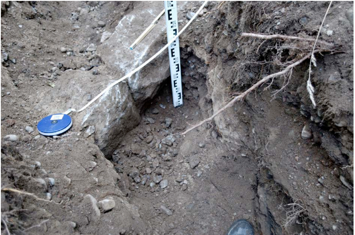
Kuva 5. Rakennuksen perustuskaivantoa. Kuvattu lännestä. AKDG3322_041
