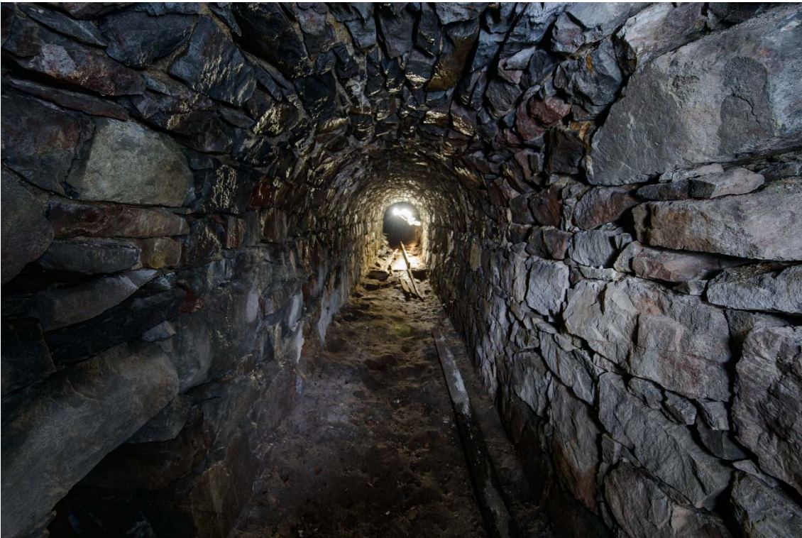
Maanalainen tunneli, jota käytettiin vedenpoistoon telakka-altaasta. (AKDG3646:8)
