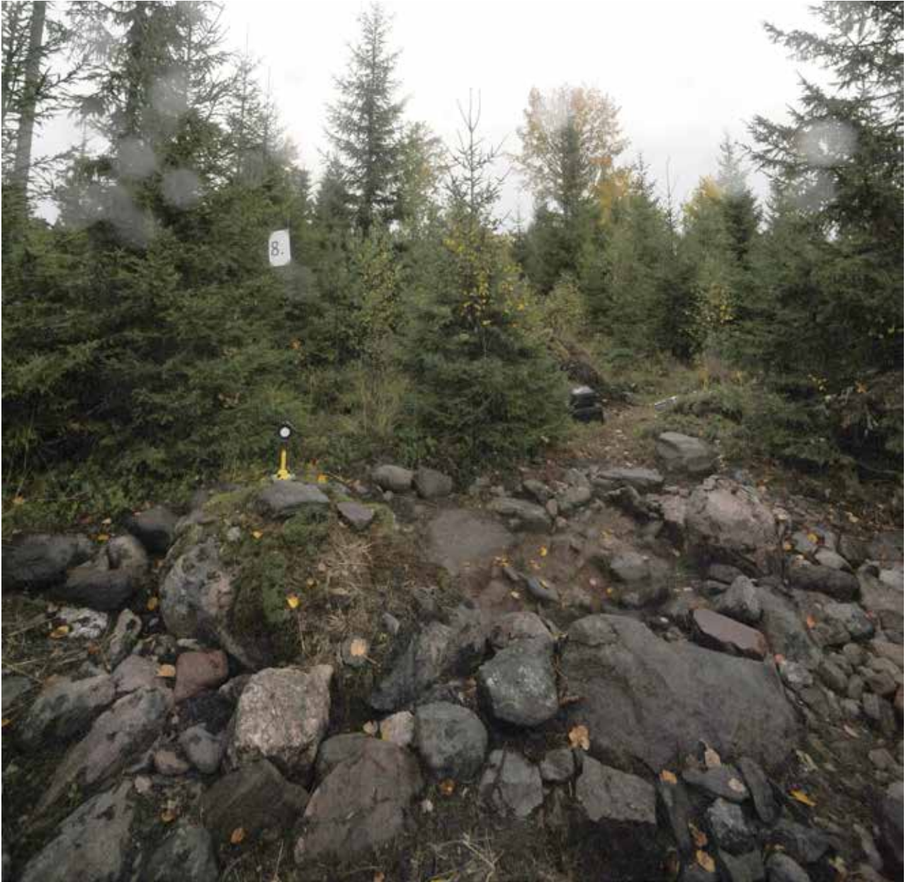
Kuva 3. Alue 2013_A. Yleiskuva röykkiöstä 8. Rakenteet pääosin esiin otettuina. syyskuu 2013. W. K Uotila / Muuritutkimus ky.
