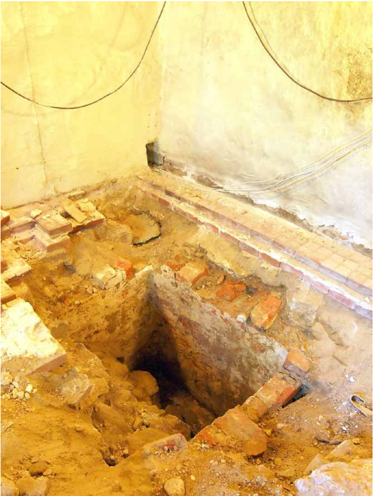
Kuva 1. Maskun kirkon sakariston lattian alta esiin tullut tiilirakenne esiin kaivettuna. YK. NE. KU
