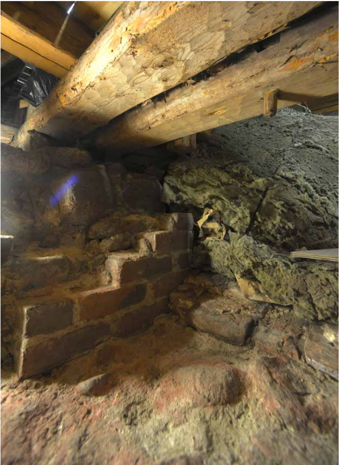
Kuva 7. Maskun kirkon ullakko. Sakariston eteläseinän tiiliaukon itäpieli esiin otettuna. detalji. NW. KU.
