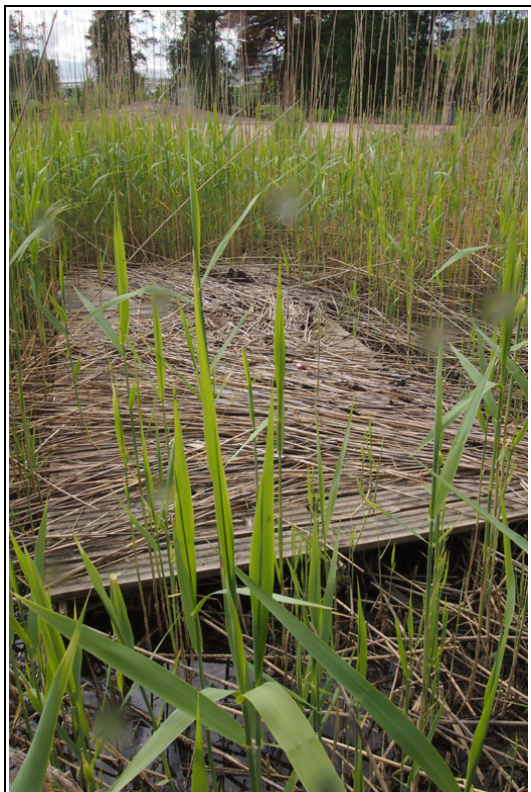
Kuva 8. Uimarannan kaislikkoon ajautunut laituri. Kuva Rami Kokko.
