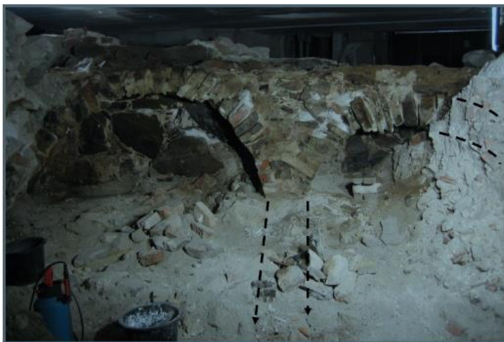
Kuva 2. Alue 22 kaivaukset paljastivat kesällä 2013 kellarin päädyistä kaksi suurta holvia. Ennen kaivauksia nämä holvit näyttivät lähinnä seinään muuratulta komeroilta. Nyt näyttää siltä että tässä kellarissa onkin ollut kaksi erillistä tilaa, jotka muodostuvat kahdesta rinnakkaisesta tynnyriholvista.
