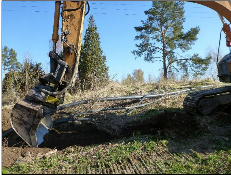
Pintamaiden koneellista poistoa. Kuvattu pohjoiseen.
