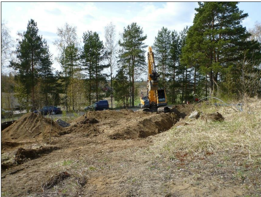
Kaivantotyömaa kuvattuna länteen.
