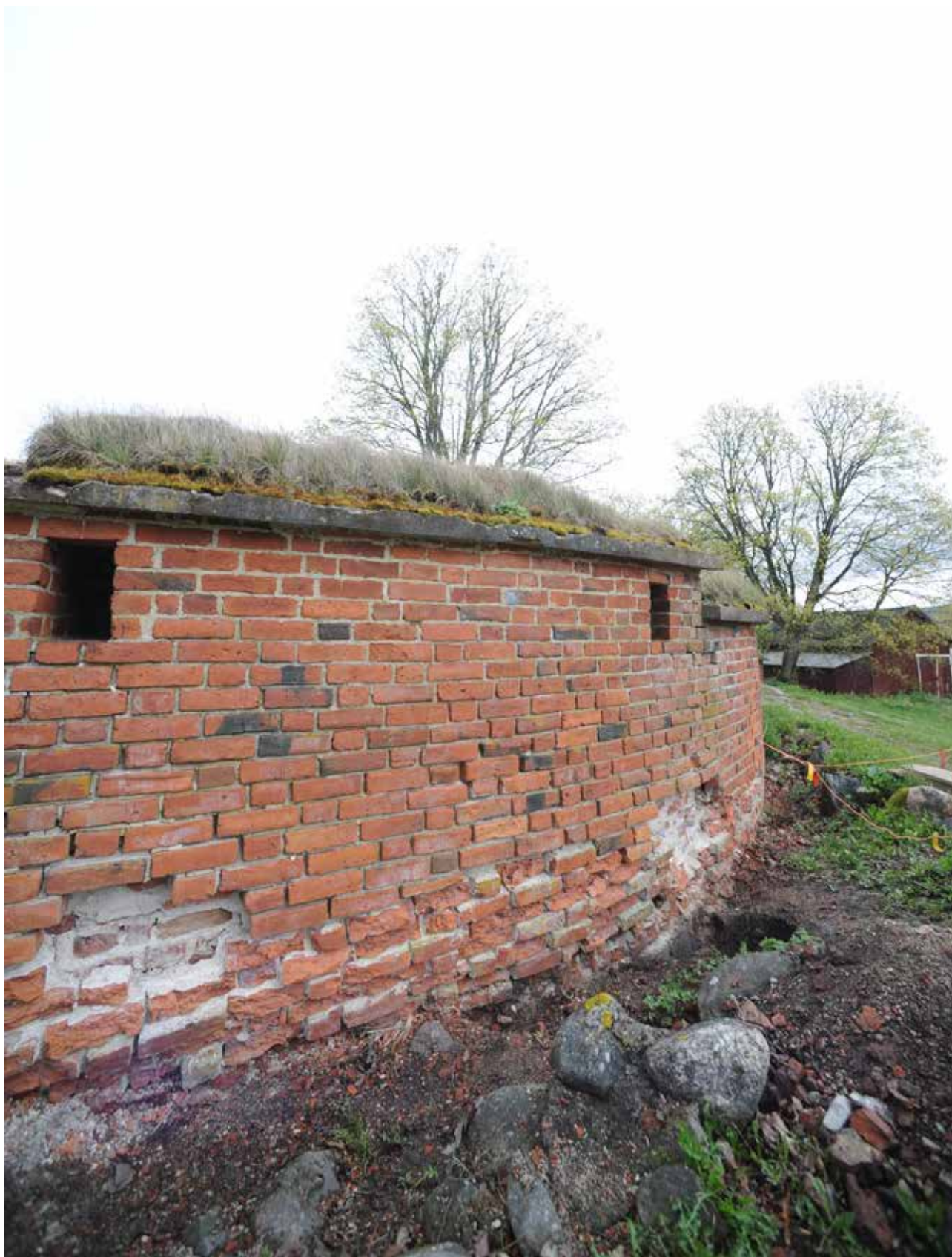
Kuva 6. Eteläisen esilinnan ulkomuuri keväällä 2014. Vauriokohde 2 puhdistettuna. YK. SW. KU.
