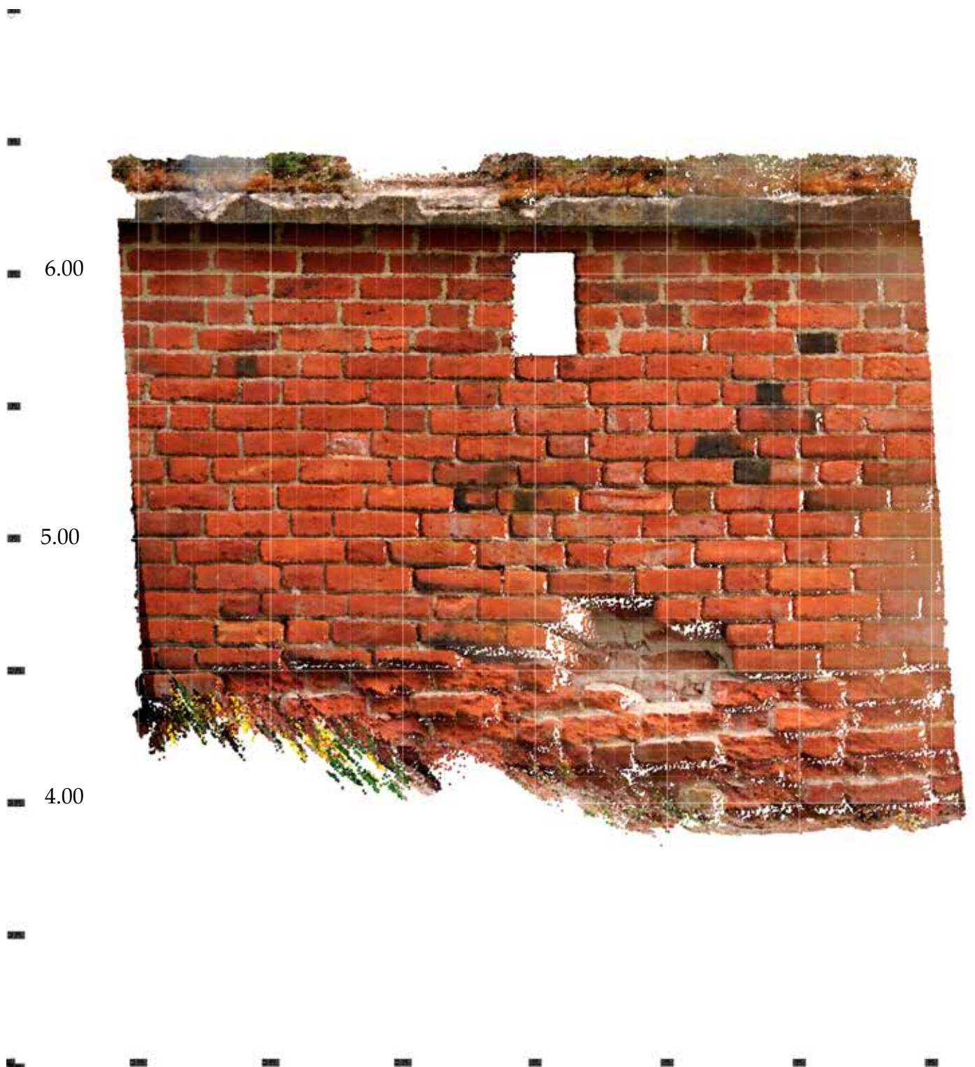
Karttakuva 2. Kuusiston linnanraunioiden eteläisen esiinnan kehämuurin ulkopinnan rapautunut vaurioalue 2.
