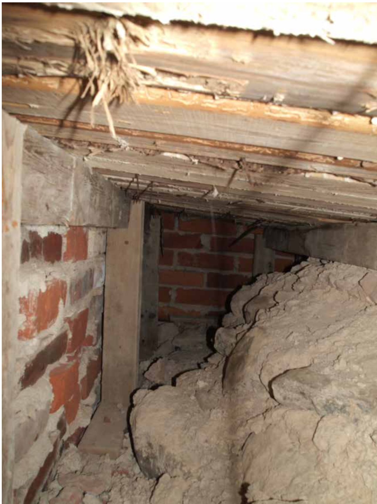
Kuva 13. Eteläisen esilinnan ulkomuuri keväällä 2014. Tiilisen korjausosan sisäosan rakenteiden tilanne. W. KU.
