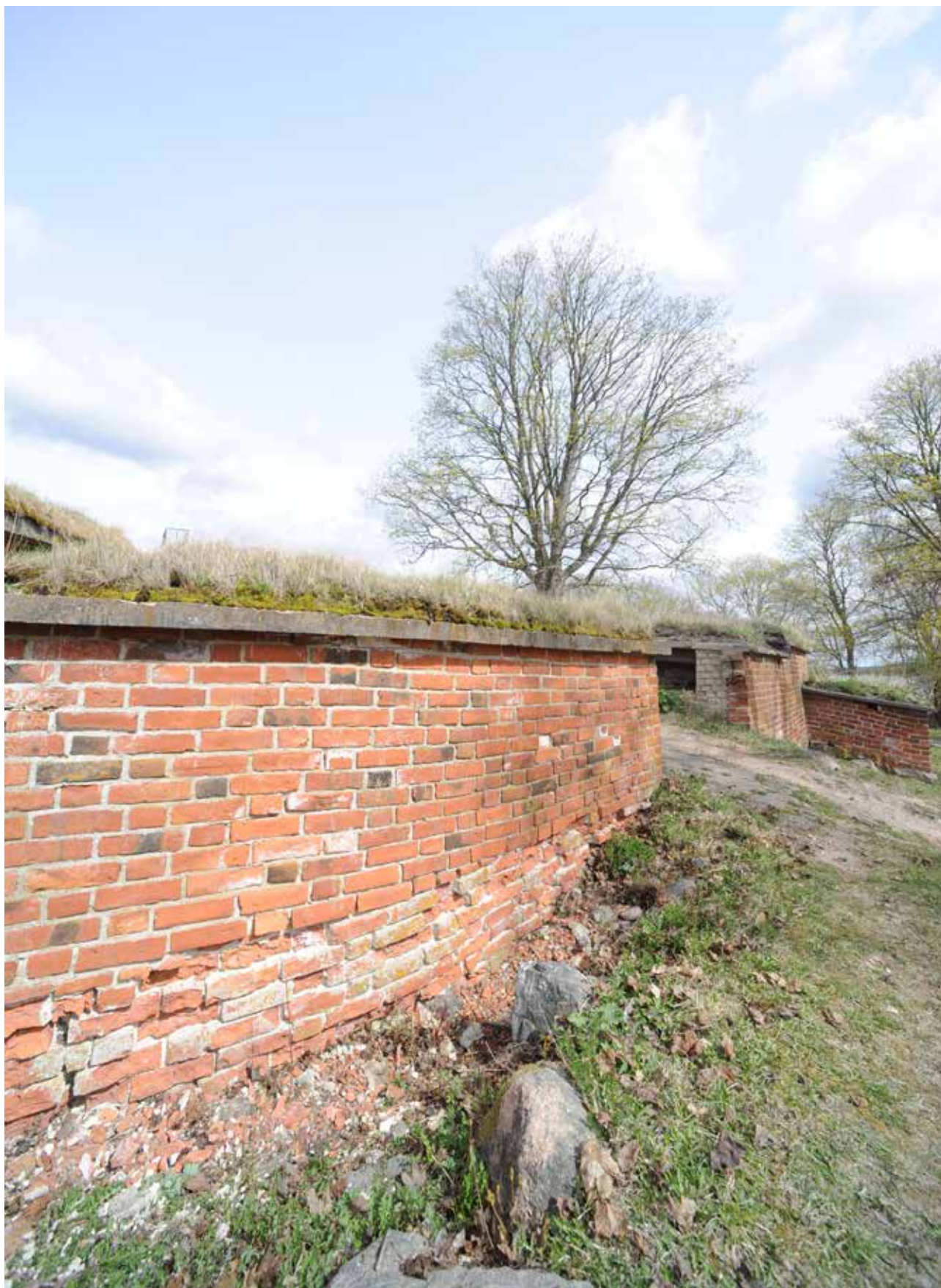
Kuva 4. Eteläisen esilinnan ulkomuuri keväällä 2014. Tiilirakenteen itäinen osa. YK. SW. KU.
