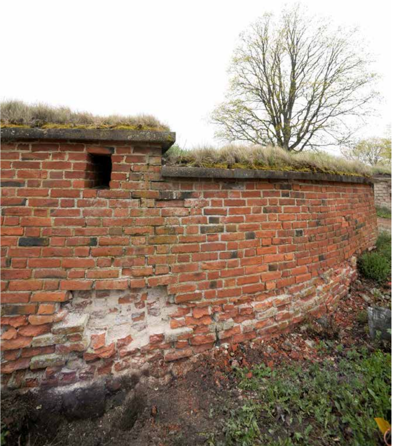
Kuva 5. Eteläisen esilinnan ulkomuuri keväällä 2014. Vauriokohde 1 puhdistettuna. YK. S. KU.
