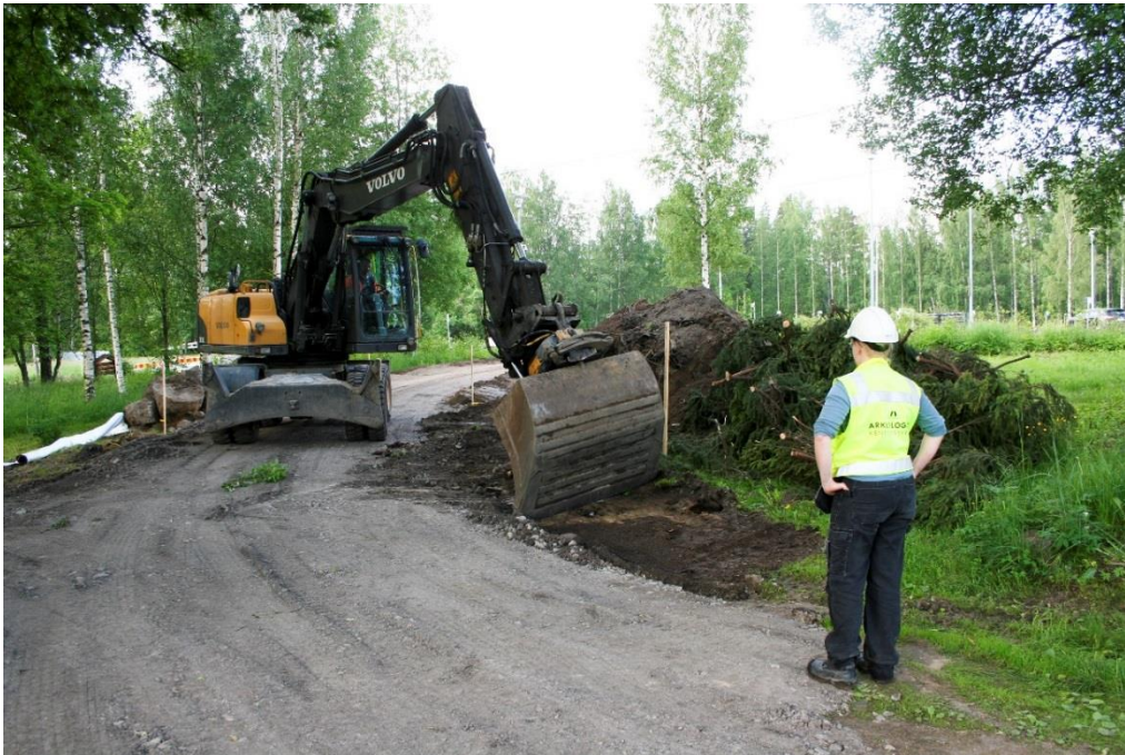
Kuva 1. Uuden tielinjan luoteispäähän kaivettiin oja viemäröinnille. Tuija Väisänen valvoo kaivutyötä. Kuvattu itään. Kuva: Satu Koivisto/ARKE (AKDG 3711:14).
