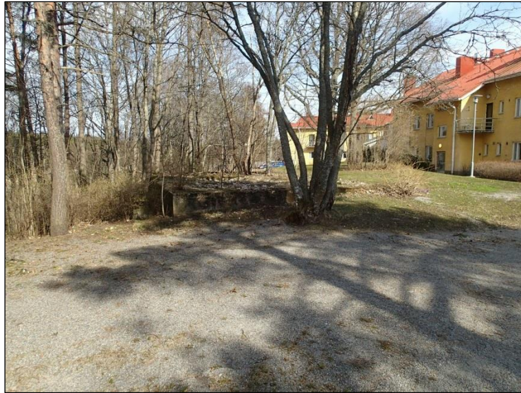
Päärakennuksen pohjoispuolella oleva betoninen rakennuksen pohja.
