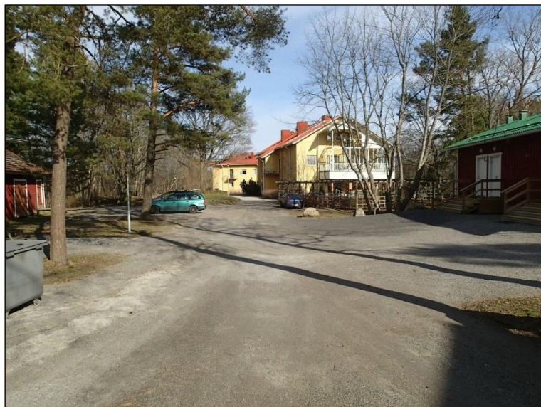
Päärakennuksen länsipuolelta itään.
