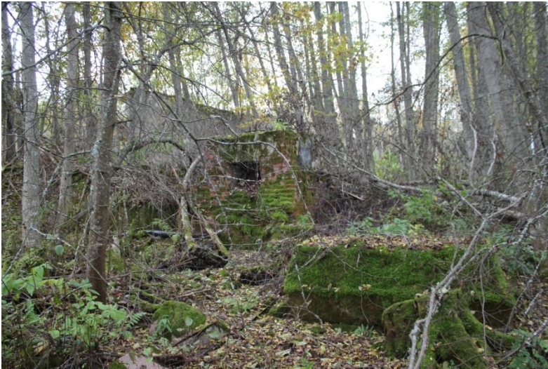
Kuva 21. Konehuoneen ja uittokanavan välissä olevia rakenteita. Kuvattu lounaaseen.
