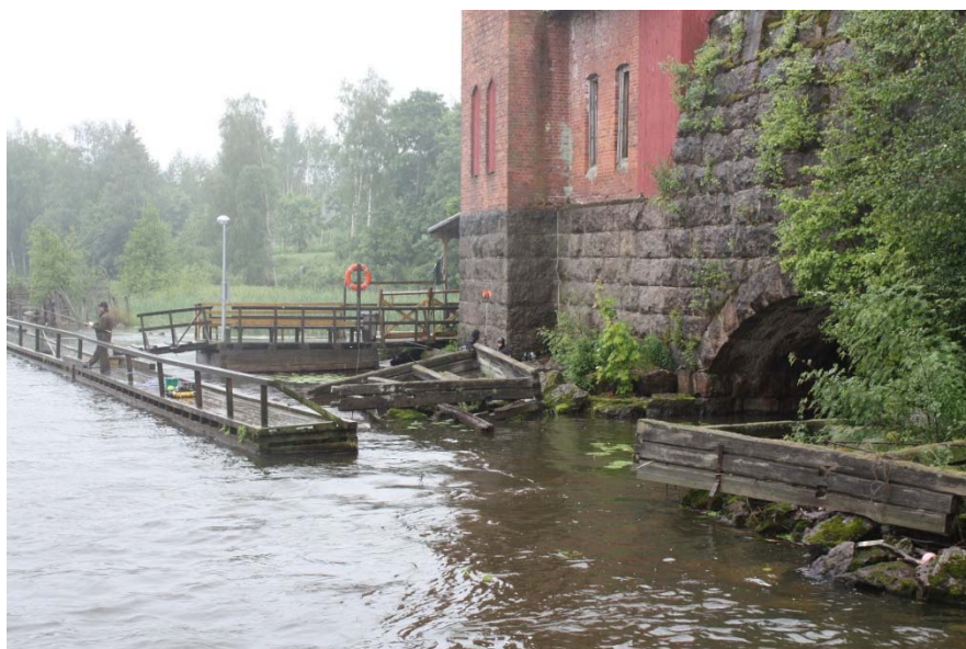
Kuva 1. AKMA201405:1. Taustalla vuonna 1906 rakennettu vanha voimalarakennus. Kuvan oikeassa laidassa näkyy hirsiarkku 2 ja kuvan keskivaiheilla hirsiarkku 1. Kuvan vasemmassa reunassa on pitkä kalastuslaituri ja sille johtava laituri, joka on perustettu hirsiarkun päälle. Kuva Petro Pesonen.
