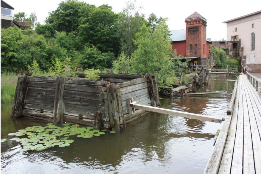
Kuva 11. AKMA201405:33. Etualalla parhaiten säilynyt hirsiarkku. Tutkimusalue sijaitsee kuvassa taka-alalla. Kuva Petro Pesonen.
