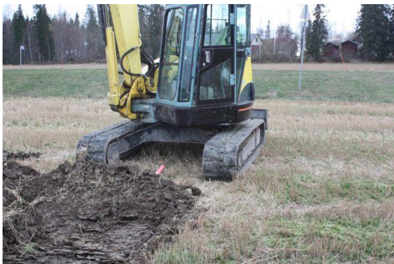
AKDG3900:22. Kaivaminen lopetettiin noin 20 metriä ennen Loimaantien reunaa. Pohjoisesta. Kuva Esa Mikkola, Arkeologiset kenttäpalvelut 23.10.2014
