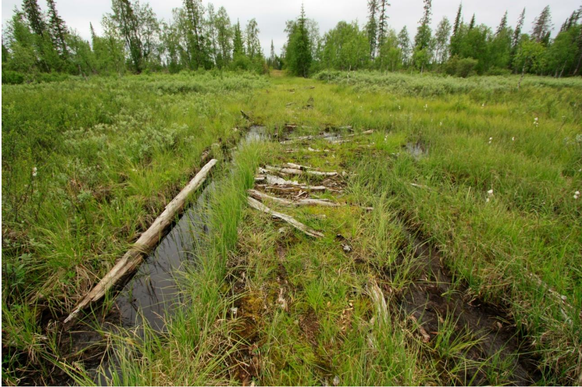
Kuva 231. Kapulatie, jossa useampia kerroksia. Tie edelleen ainakin osin käytössä.
