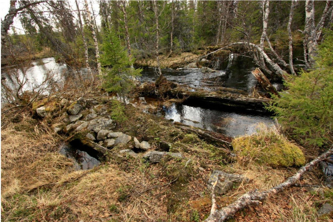
Kuva 118. Tammen itäosan tukirakenteita sekä uittokanavaa, kuvattu koillisesta.
