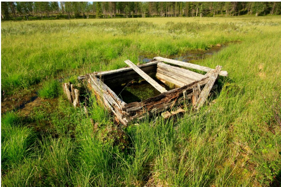
Kuva 91. Kaivo, kuvattu koillisesta.
