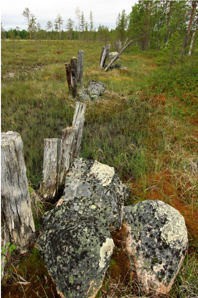
Kuva 123. Patovallin puisia ja kivisiä tukirakenteita.
