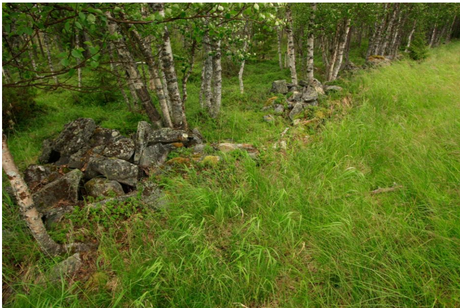
Kuva 108. Tammen patovallin kivisiä tukirakenteita.
