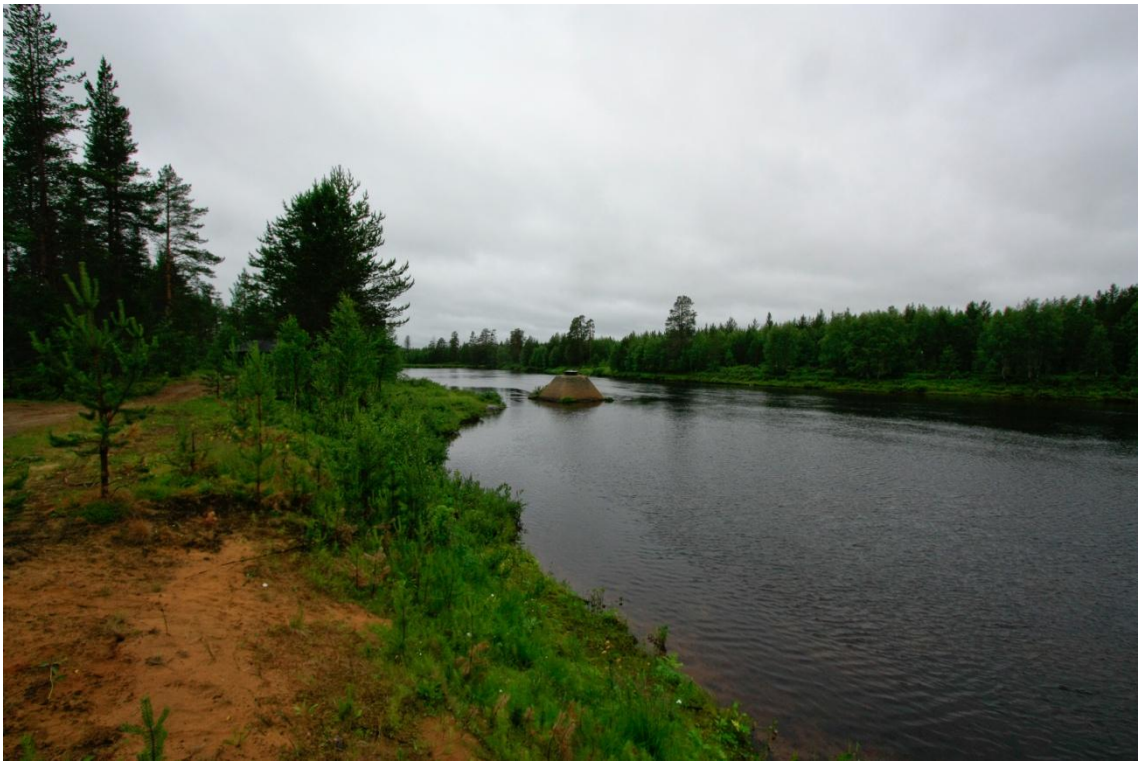
Kuva 127 Betoninen uittovastuu Kemijoen. Kuvattu idästä.
