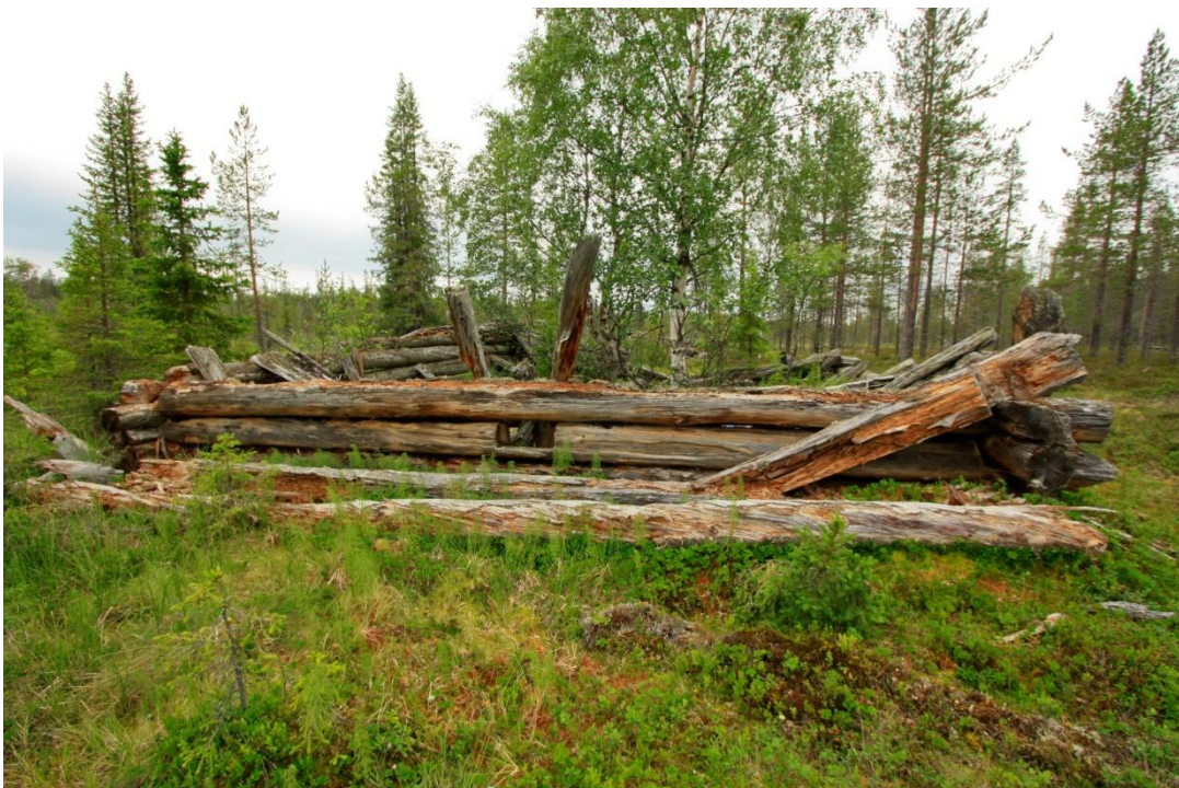
Kuva 98. Tallin itäseinän paskaluukku, kuvattu idästä.
