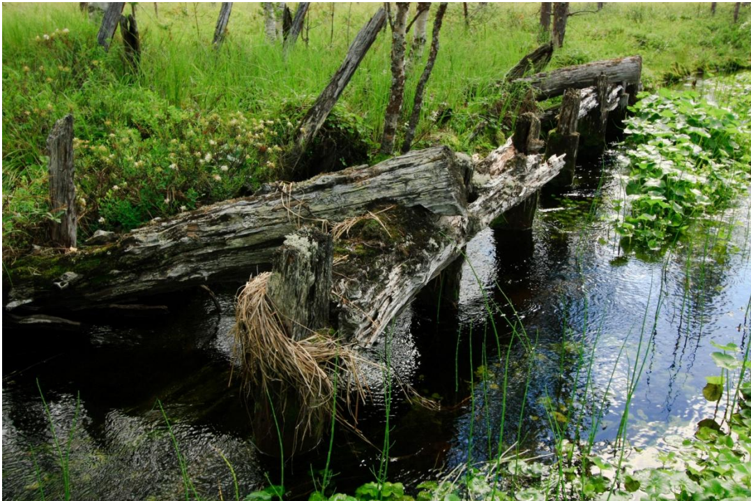
Kuva 221. Yksityiskohta Vouhtujoen sillan rakenteesta.
