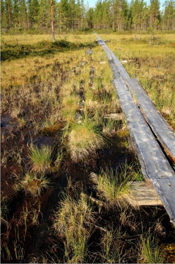
← Kuva 130. Jänesojan pumppuaseman ja Tulppion välissä veturitien linjauksella kulkee myös yleinen retkeilyreitti. Tässä veturitien tukirakenteet näkyvät reitin pitkospuiden vieressä.
