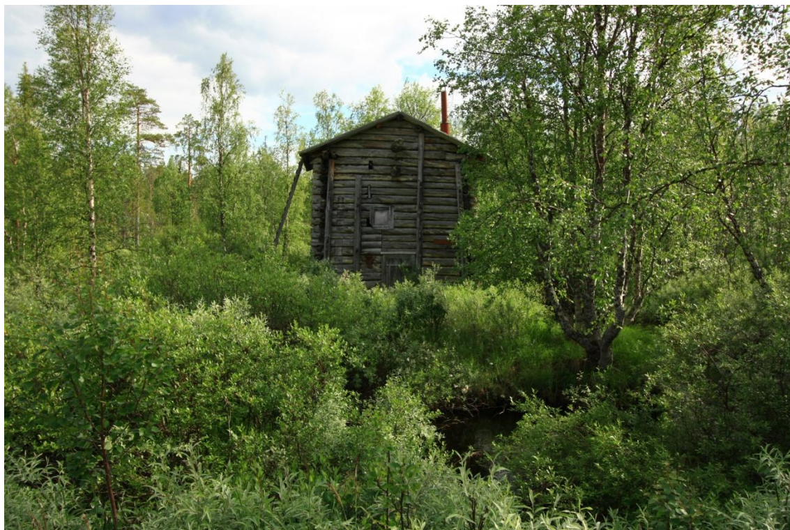
Kuva 248. Jänesojan pumppuasema keskikesällä. Kuvattu pohjoisesta.
