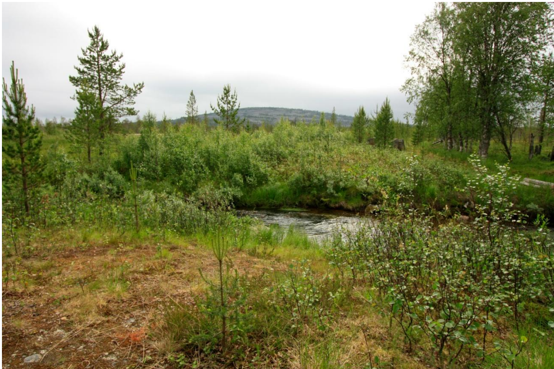
Kuva 122. Tammen päälle rakennettu tie. Patovallin tukirakenteita näkyvissä kuvan oikeassa laidassa. Taustalla kohoaa Rannimmainen Sotatunturi.
