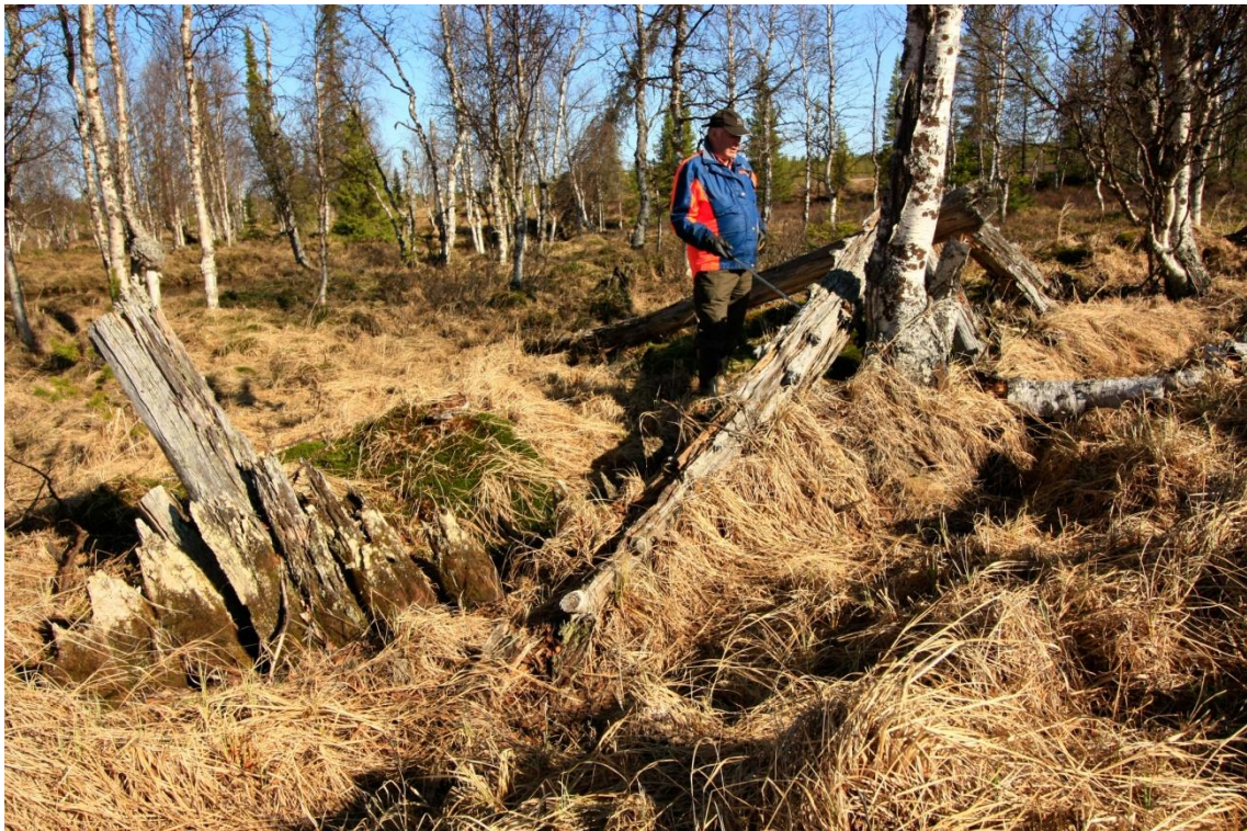
Kuva 120. Erkki Heikkilä tutkii patovallin puisia tukirakenteita, kuvattu eteläkaakosta.
