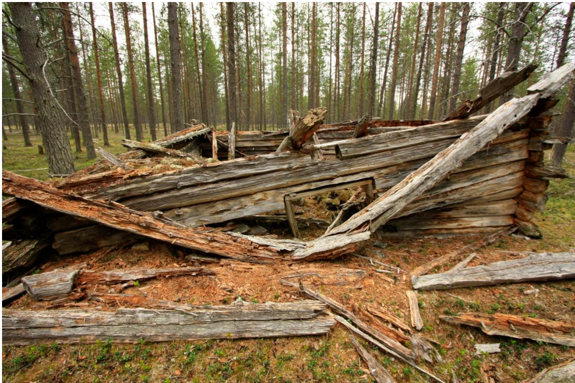
Kuva 143. Kämpän eteläseinä ja mahdollinen oviaukko, kuvattu etelästä.
