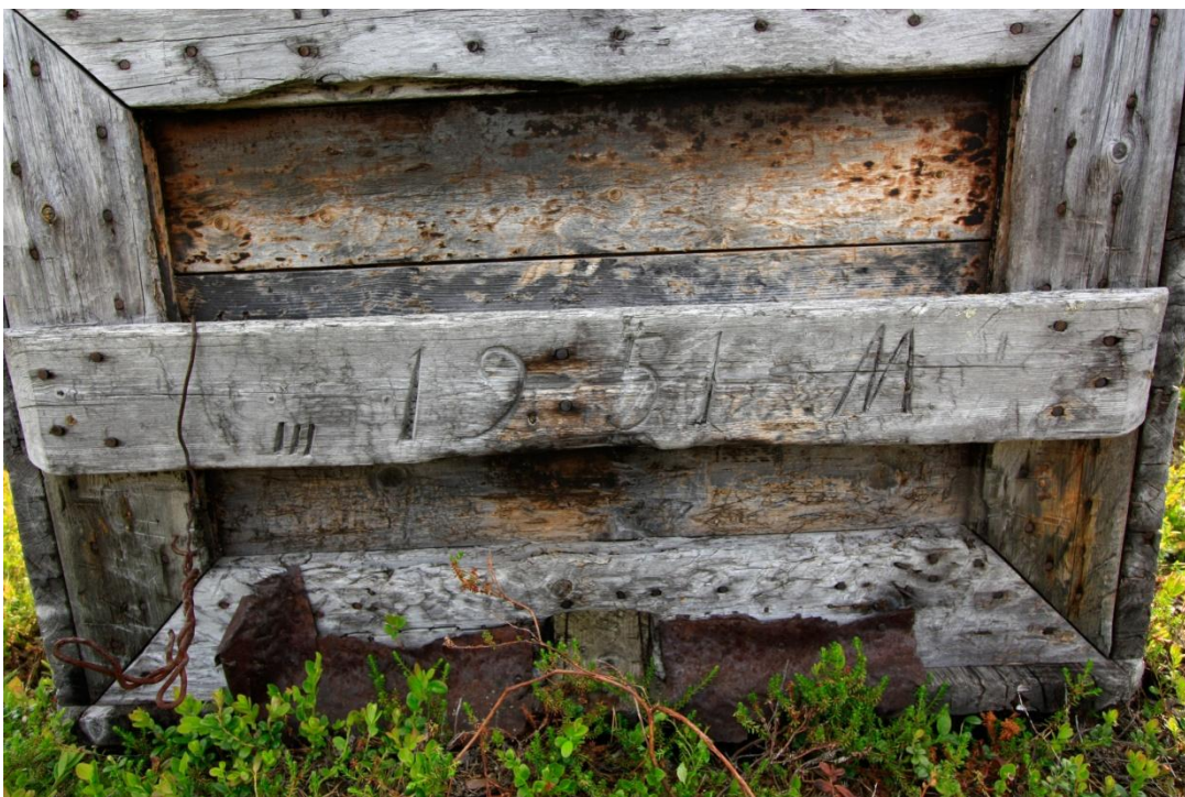
Kuva 87. Yksityiskohtakuva päädyssä olevasta vuosiluvusta 1951.
