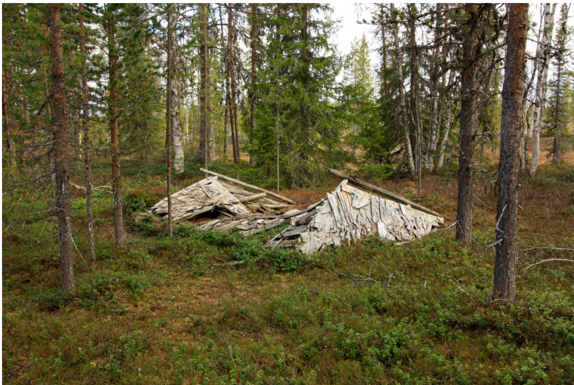
Kuva 56. Romahtanut päreestä tehty ulkovessa. Vielä joitain vuosia sitten se on ollut pystyssä. Kuvattu etelästä.
