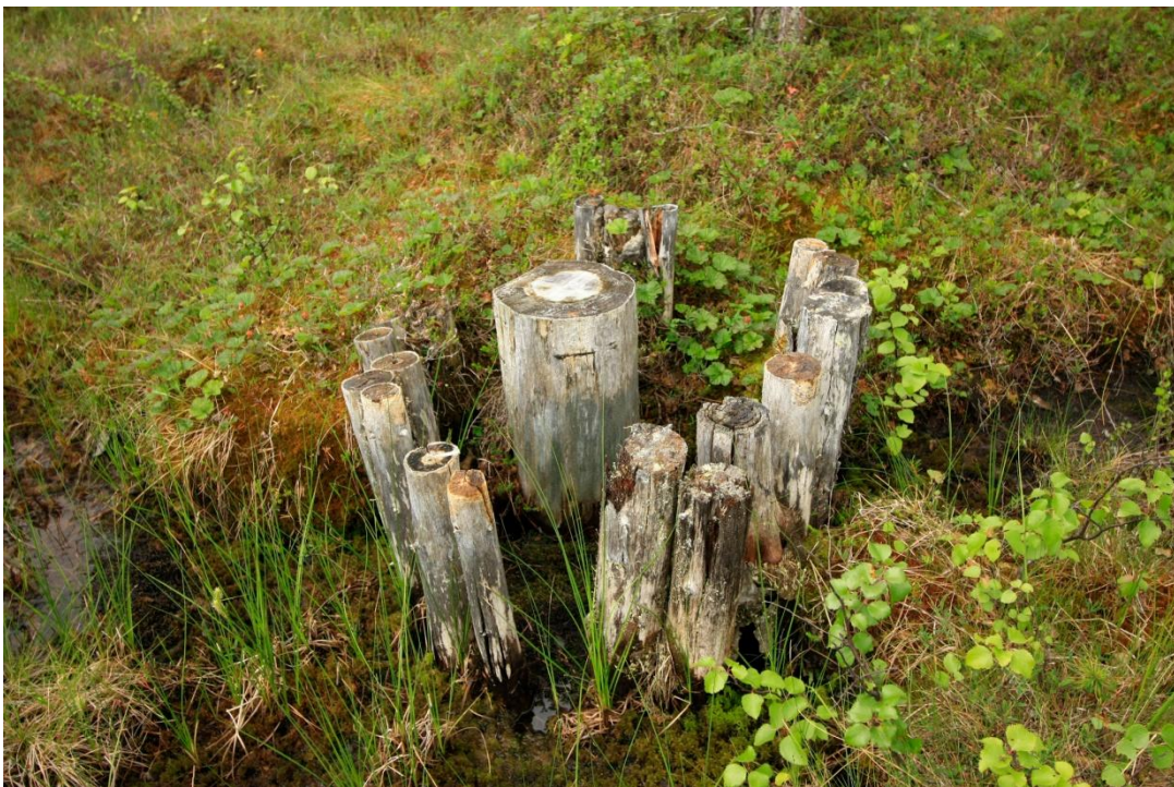
Kuva 124. Vanhan Tulppiontien laidasta löytyi muutamia vanhoja puhelintolppoa, jotka on tuettu suohon puilla.
