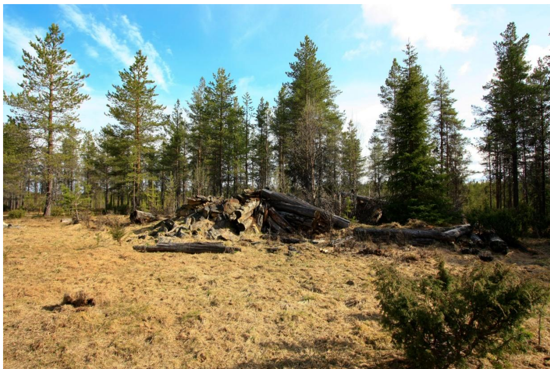
Kuva 14. Kämpän pohjoisosa, jossa L-kirjaimen muoto näkyy hyvin. Kämpän parhaiten pystyssä olevassa seinässä näkyy vielä ikkuna. Kuvattu pohjoisesta.
