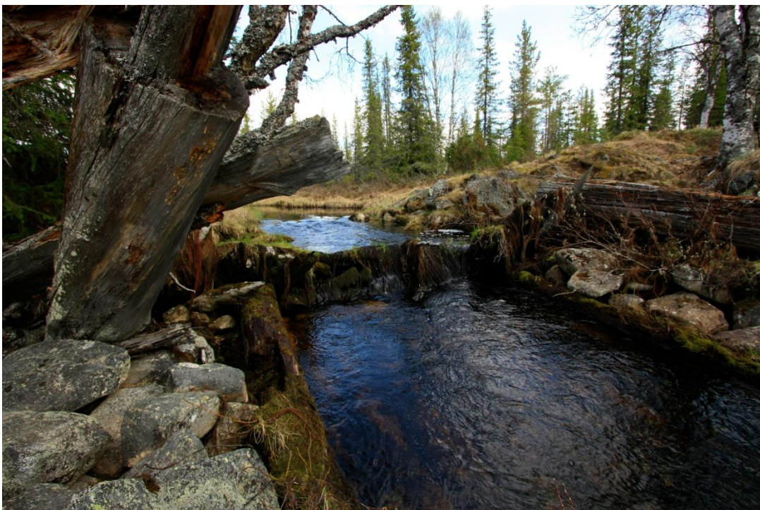
Kuva 119. Yksityiskohta tammen länsiosan uittorännistä.
