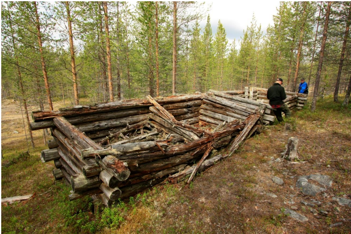
Kuva 203. Reutuvaaran maalitauluna toiminut rakenne, kuvattu etelästä.
