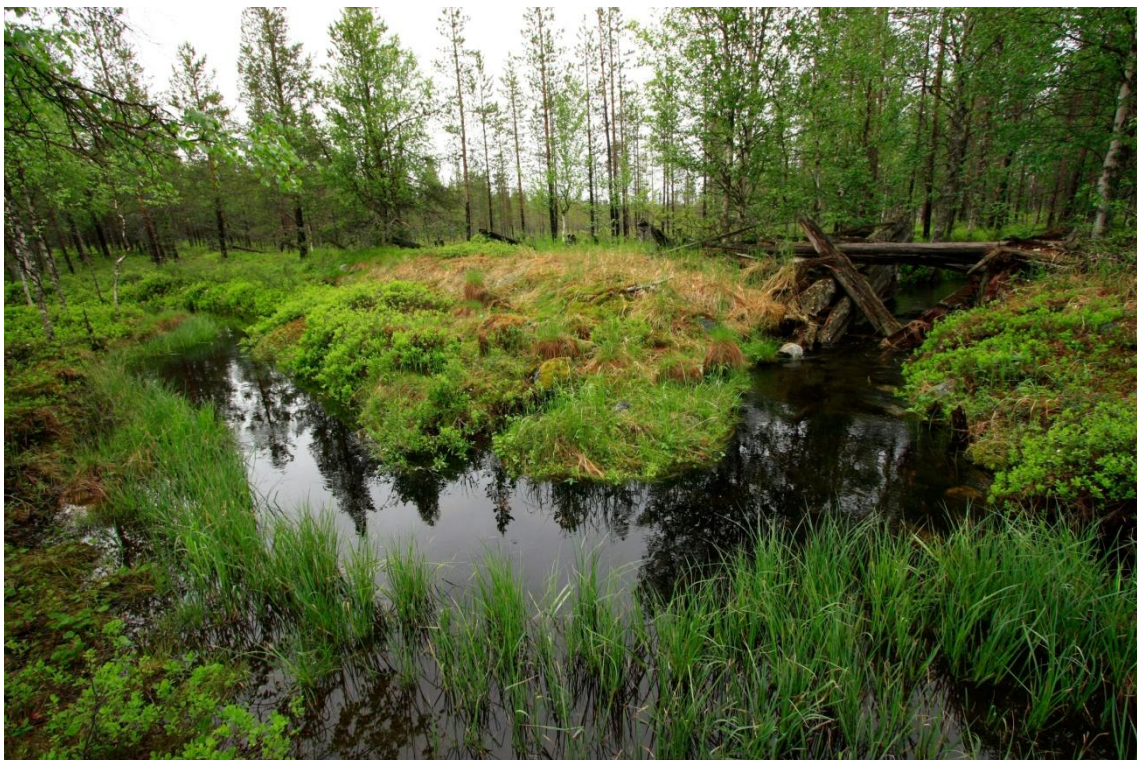
Kuva 115. Tammi ja länsipuoleista patovallia, kuvattu lounaasta.
