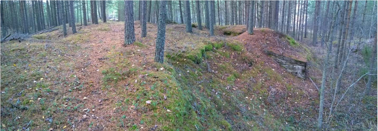
AKDG 3927:6. Romahtanutta betonirakennetta keskimmäisen ratapenkan länsipäässä, idästä. Kuvaaja: Petro Pesonen.
