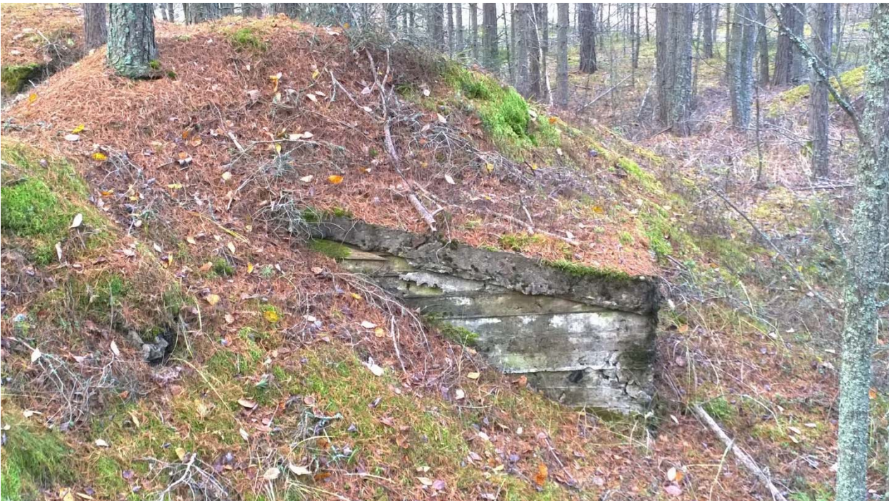
AKDG 3927:7. Betonirakenne keskimmäisen ratapenkan länsipäässä, kaakosta. Kuvaaja: Petro Pesonen.
