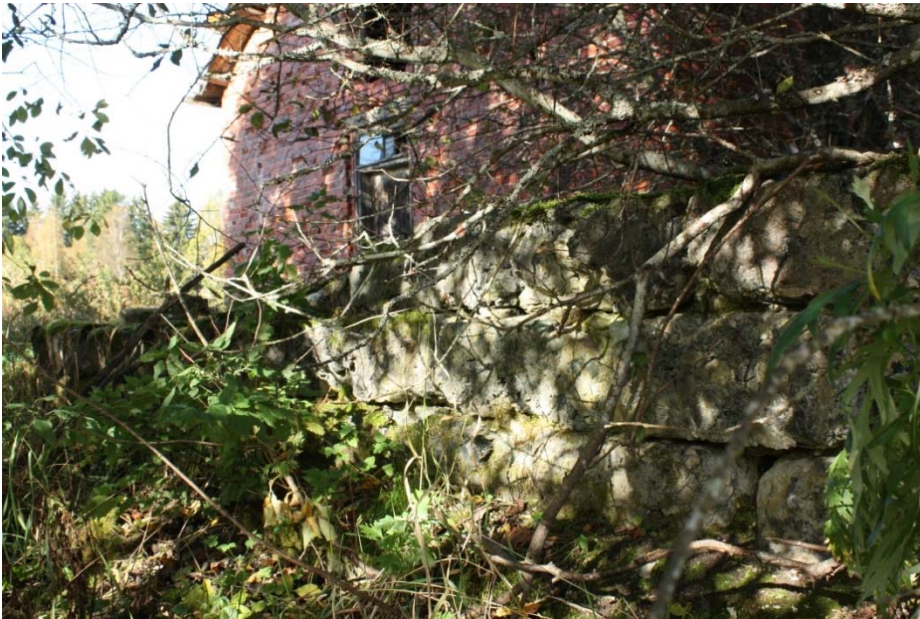
AKDG 3836:22. Edustalla kuonaharkkoista tehdyn rakennuksen kivijalka, taustalla tiilirakennus, joka on viimeksi toiminut eläinsuojana, kaakosta. Kuvaaja: Satu Koivisto.
