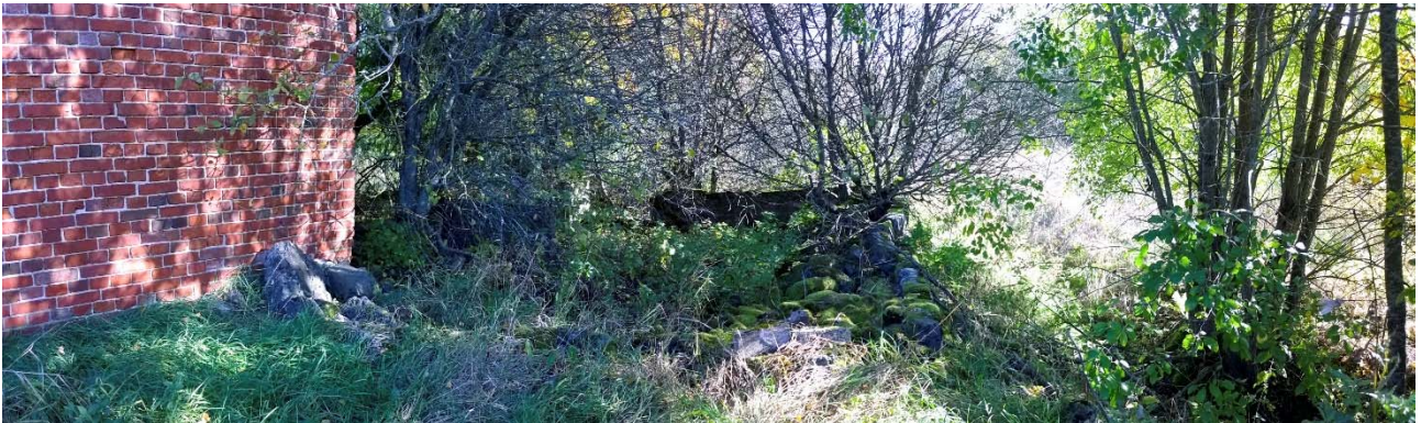
AKDG 3836:21. Kuonaharkkoista ja tiilistä rakennetun talon perustukset tiilirakennuksen kulmalla, lounaasta. Kuvaaja: Satu Koivisto.
