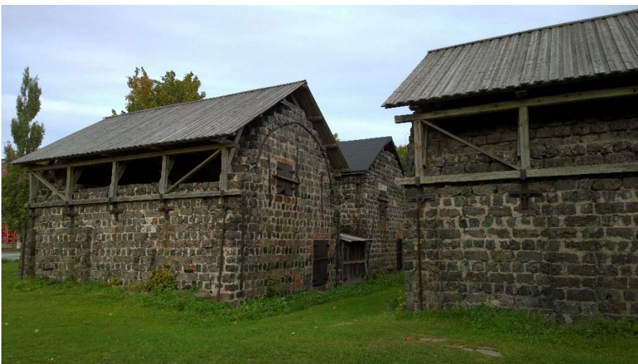
AKDG 3836:28. Kuonaharkkoista rakennettuja taloja (uuneja) Taalintehtaalla. Kuvaaja: Satu Koivisto.
