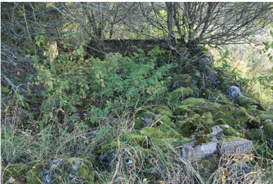
AKDG 3836:25. Kuonaharkkorakennuksen sisäosaa, kaakosta. Kuvaaja: Satu Koivisto.
