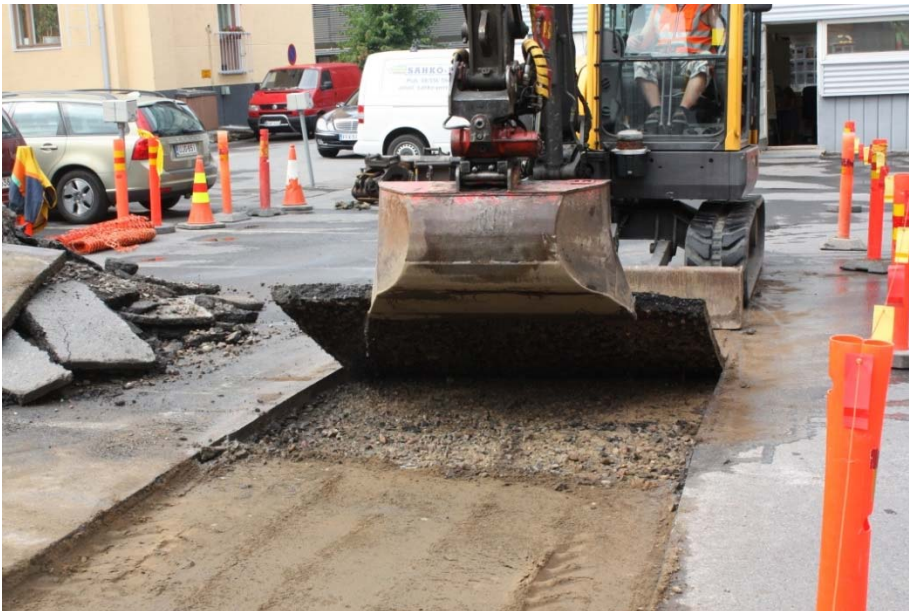
AKDG 3908:4. Asfaltinpoistoa koeojan 1 jatkosta, koillisesta. Kuvaaja: Petro Pesonen.
