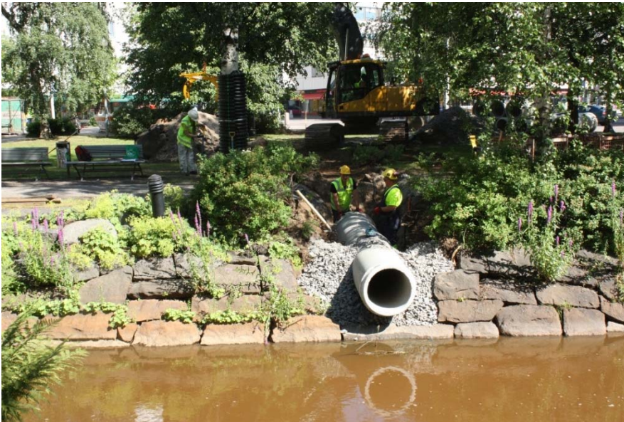
AKDG 3901:7. Hulevesiputki asennettuna, edustalla kaupunginoja, lounaasta. Kuvaaja: Petro Pesonen.
