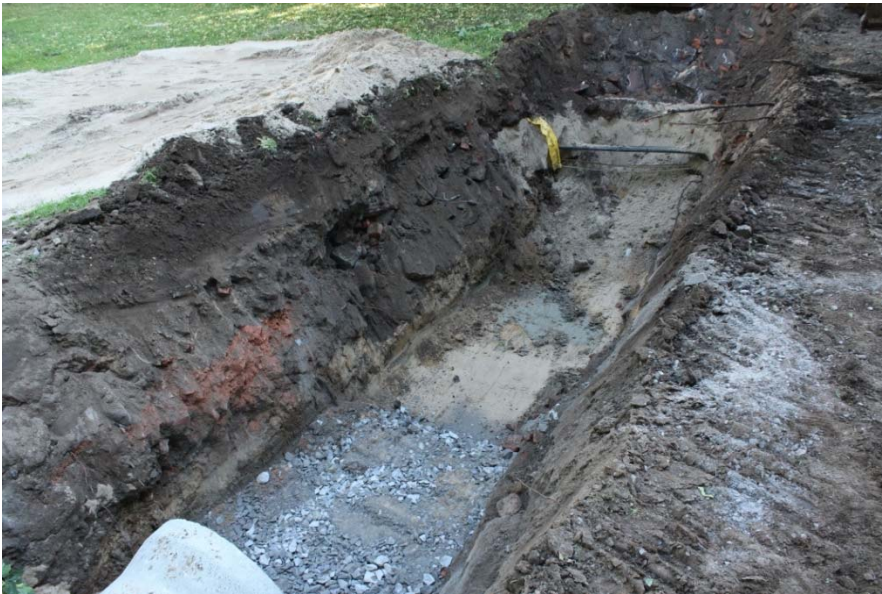
AKDG 3901:10. Hulevesiput- ken asennustapa, kaakosta. Kuvaaja: Petro Pesonen.
