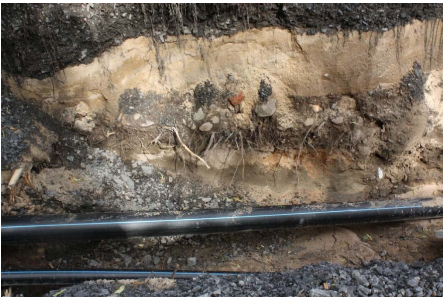
AKDG 3901:15. Puiston poh- joislaidan kaivannon profii- lissa on pintamullan alla paksu hiekkakerros, sitten purkukerros ja alla puhdas pohjahiekka, lounaasta. Ku- vaaja: Petro Pesonen.
