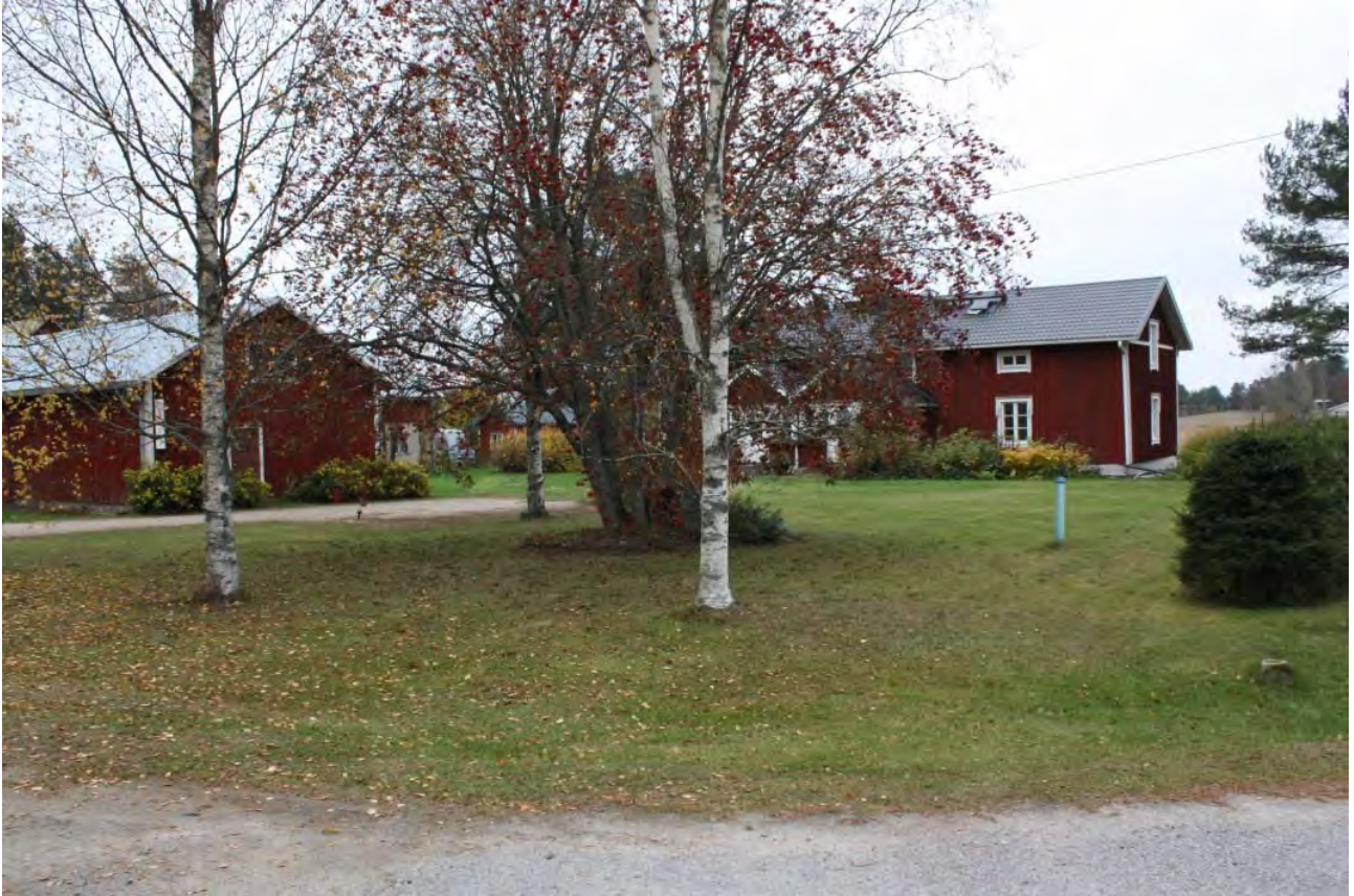
AKDG 3939:4. Hyvin säilynyt pihapiiri tien itäpuolella (Voltintie 101), luoteesta. Kuvaaja: Petro Pesonen.
