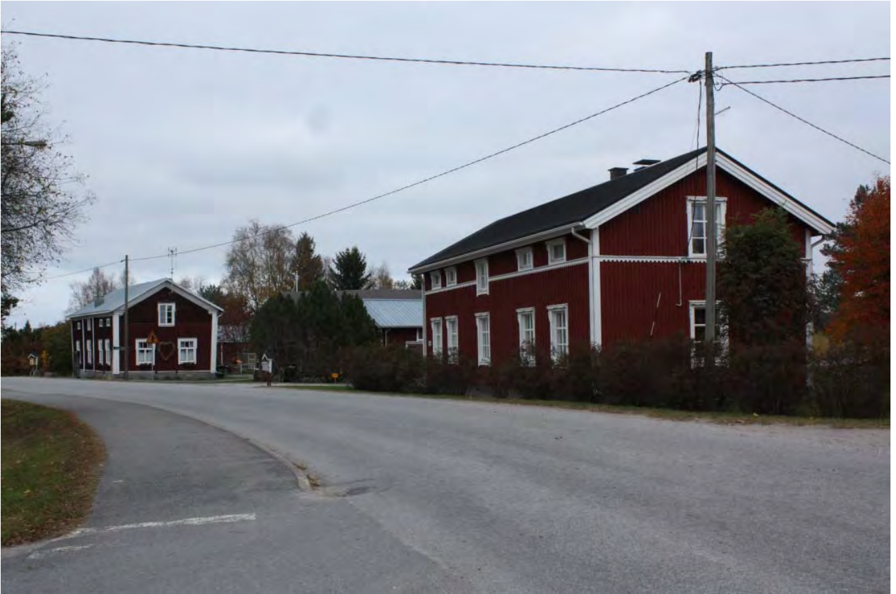
AKDG 3937:2. Knuuttilan raitti, etelästä. Kuvaaja: Petro Pesonen.
