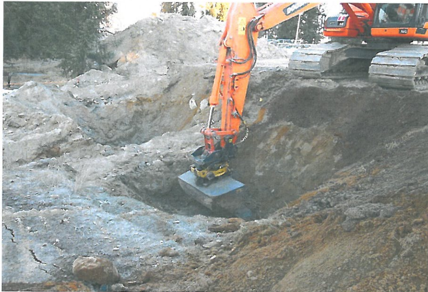
Kuva 11. Porakaivoyksiköiden kuopat lähes pohjassa.
