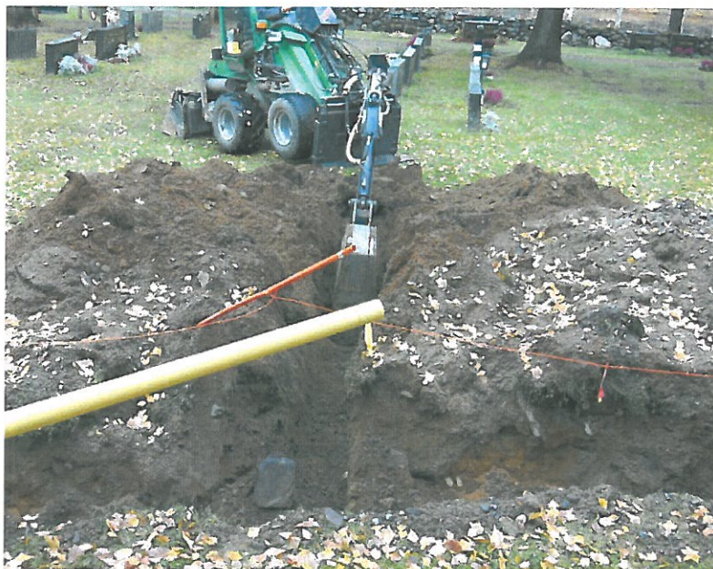
Kuva 3. KT1 kaivannon lisähaara sähkökaapeleita varten, ja josta löytyi irtoluita.
