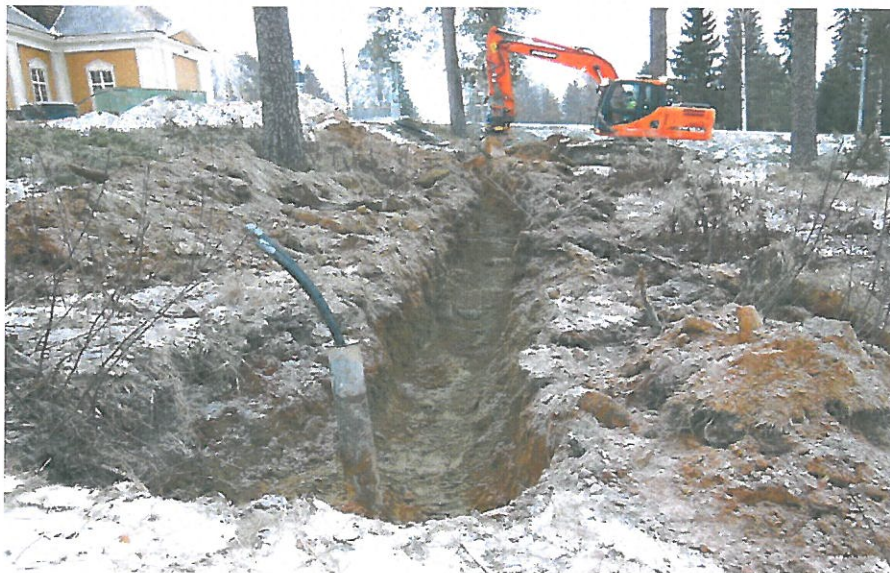
Kuva 13. Läntisin porakaivo. Kaivuri kaivaa kohti eteläisintä porakaivoa KT2 -kaivantoa pitkin.
