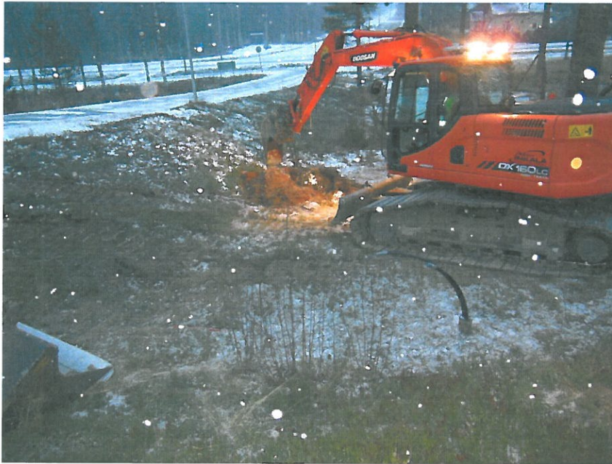
Kuva 12. Aloituskuvaa porakaivoihin liittyvistä kaivannoista.
