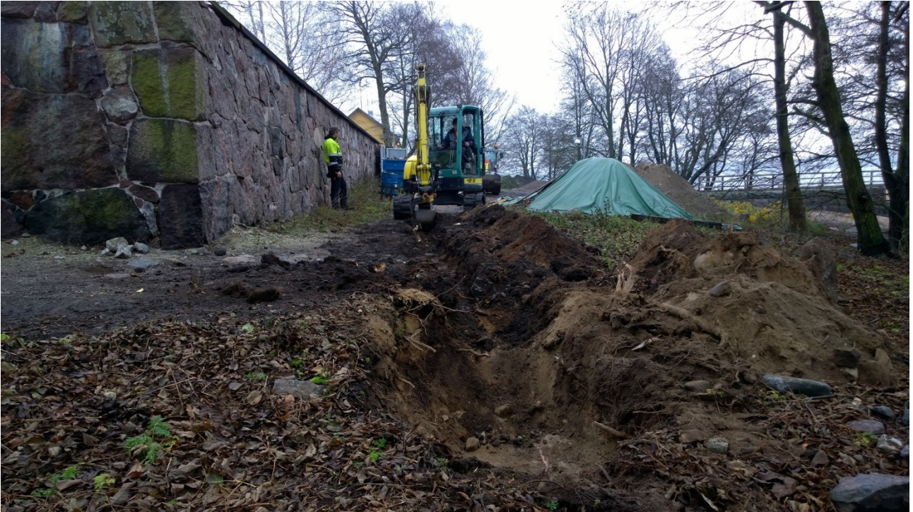
AKDG 3919:24. Kaapelikaivantoa tehdään saaren eteläosassa muurin edustalla, lännestä. Kuvaaja: Petro Pesonen.
