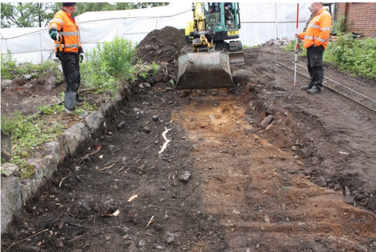
AKDG 3919:11. Seinälinjan vieressä erottuva perustusta varten kaivetun maan (musta) ja koskemattoman maan raja koillisella kaivualueella, kaakosta. Kuvaaja: Petro Pesonen.
