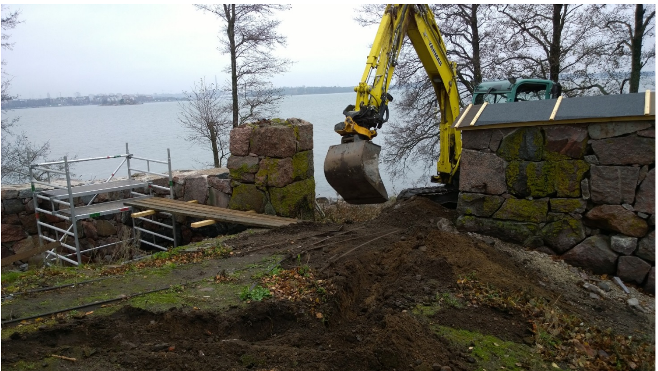
AKDG 3919:23. Kaapelikaivantoa tehdään varaston H5 pohjoispuolella, kaakosta. Kuvaaja: Petro Pesonen.
