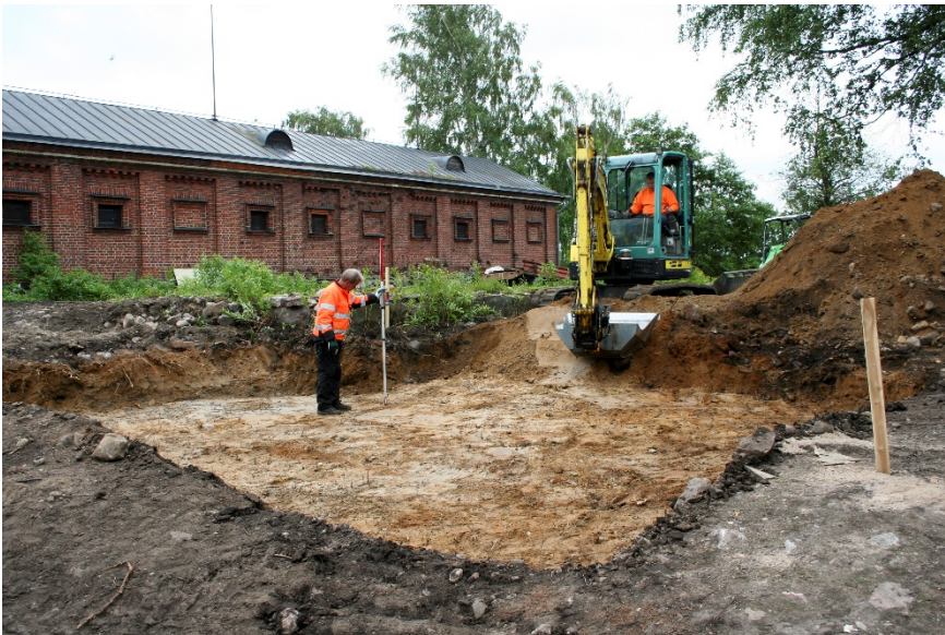
AKDG 3919:5. Juhlalavan luoteisosa kaivettuna, luoteesta. Kuvaaja: Satu Koivisto.
