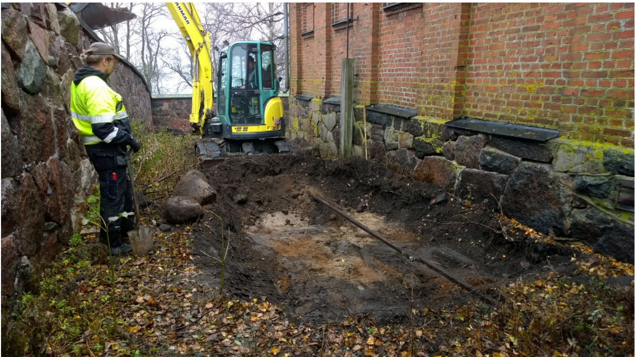
AKDG 3919:17. Kaivanto rakennuksen H3 itäseinustalla, pohjoisesta. Kuvaaja: Petro Pesonen.
