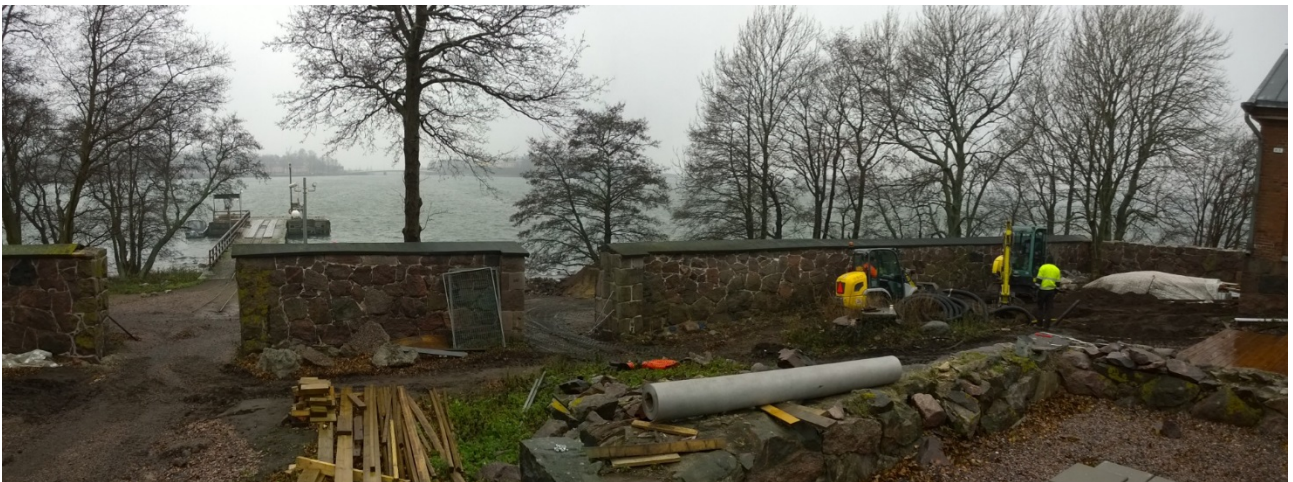
AKDG 3919:20. Kaivutyö meneillään rakennuksen H5 edustalla, koillisesta. Kuvaaja: Petro Pesonen.
