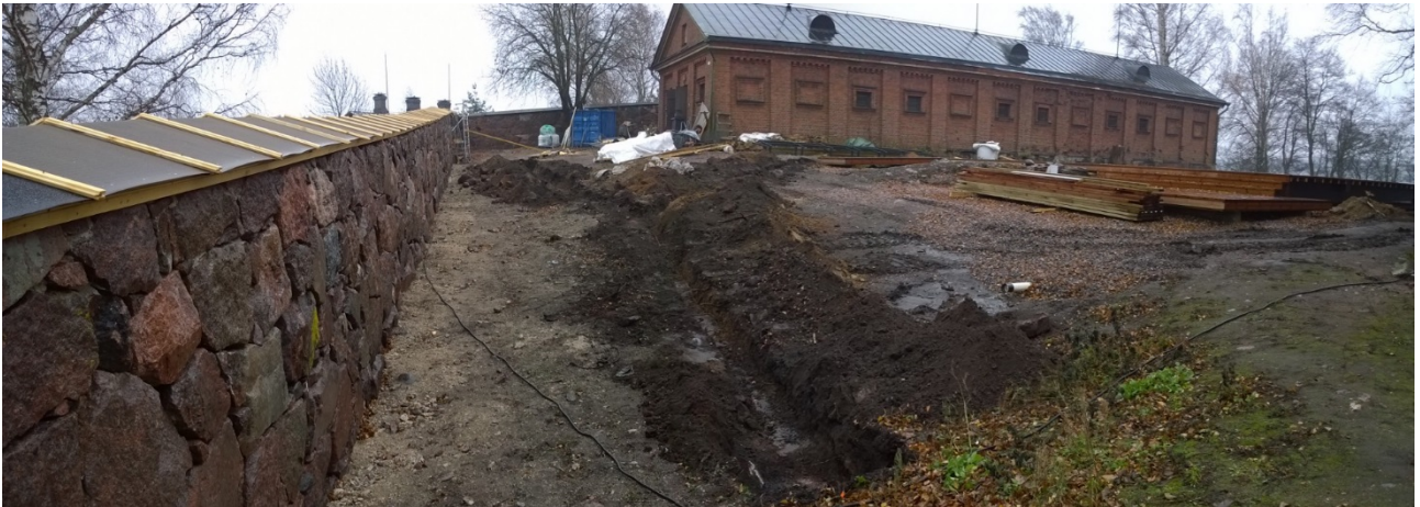
AKDG 3919:18. Kaapelikaivanto rakennusten H3 ja H5 välissä, pohjoismuurin vieressä, lännestä. Kuvaaja: Petro Pesonen.
