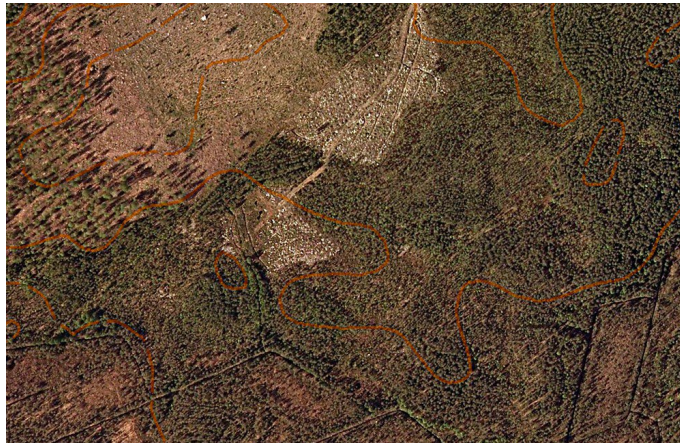
Kuva 3 a. Ortoilmakuva, voimalapaikka kuvan keskellä.
