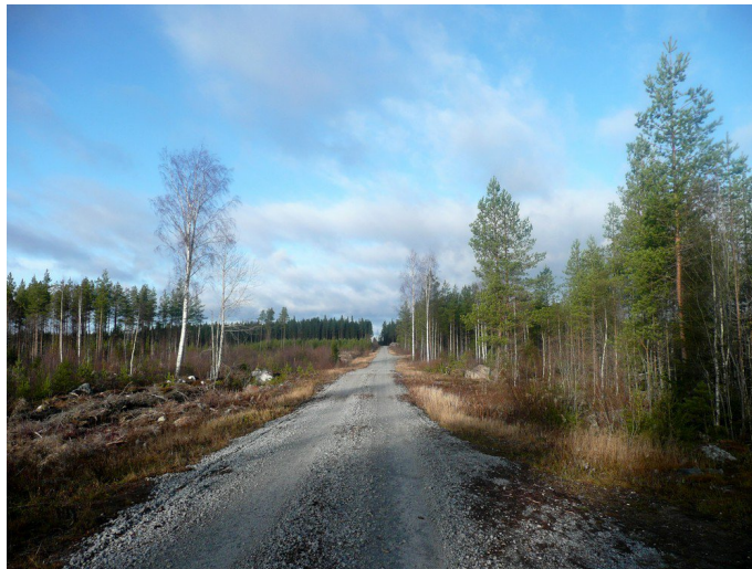
Kuva 10. Kunnostettu metsätie kuvattu pohjoiseen.
