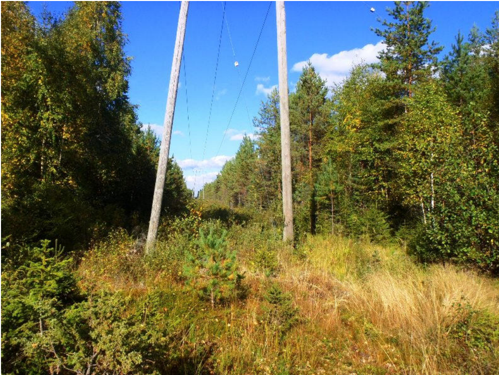
Kuva: Kohnansampaan kaatunut rajapyykki sijaitsee voimajohtolinjan alla suunnilleen kuvan keskellä. 6.9.2013. Jouni Taivainen.
