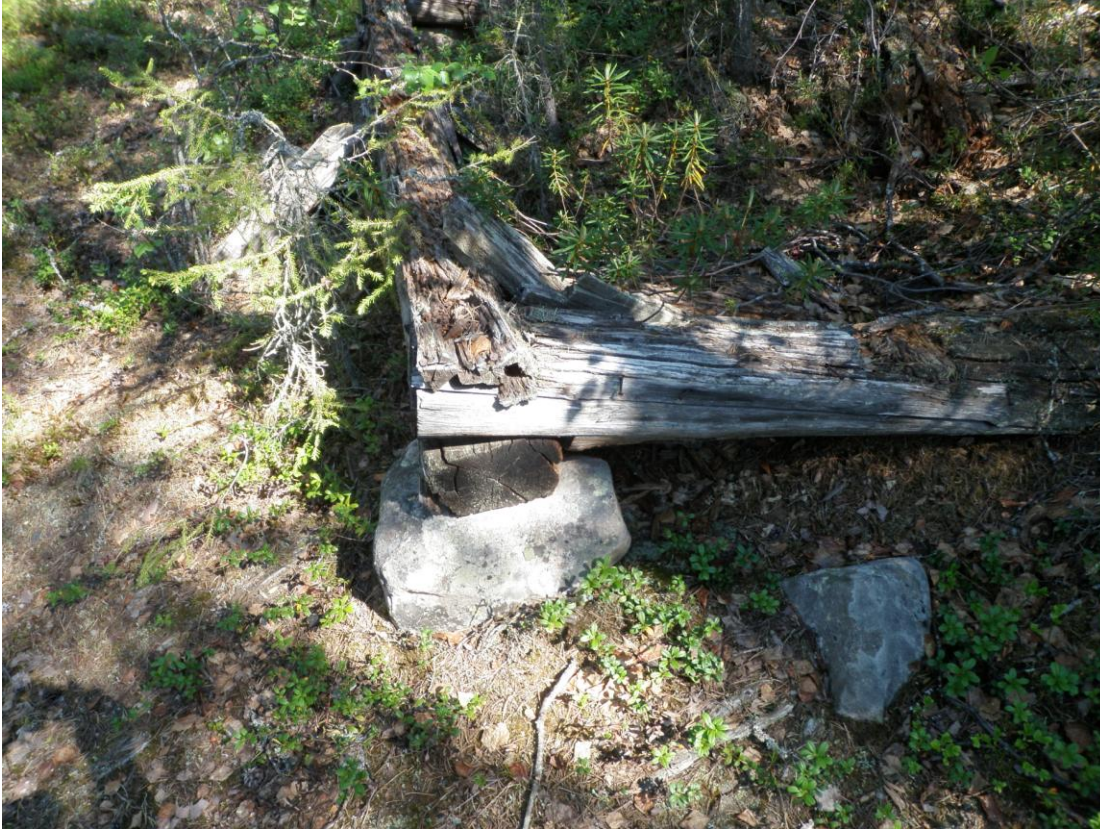
Rakennuksen nurkkasalvos lepää kivien päällä. hirsissä on vielä hieman punamultaa pinnassa.
