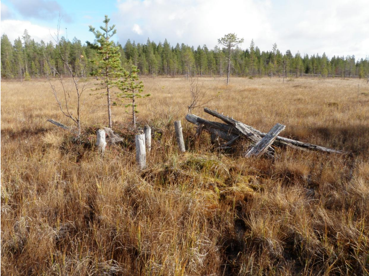
Niittypadon sulkurakenteita suota halkovan pienen ojan yllä.
