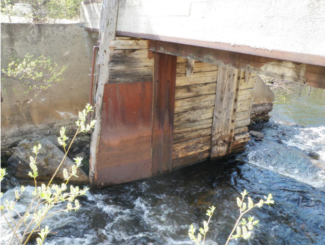
Uittopadon rakenteita nykyisen sillan alla.
