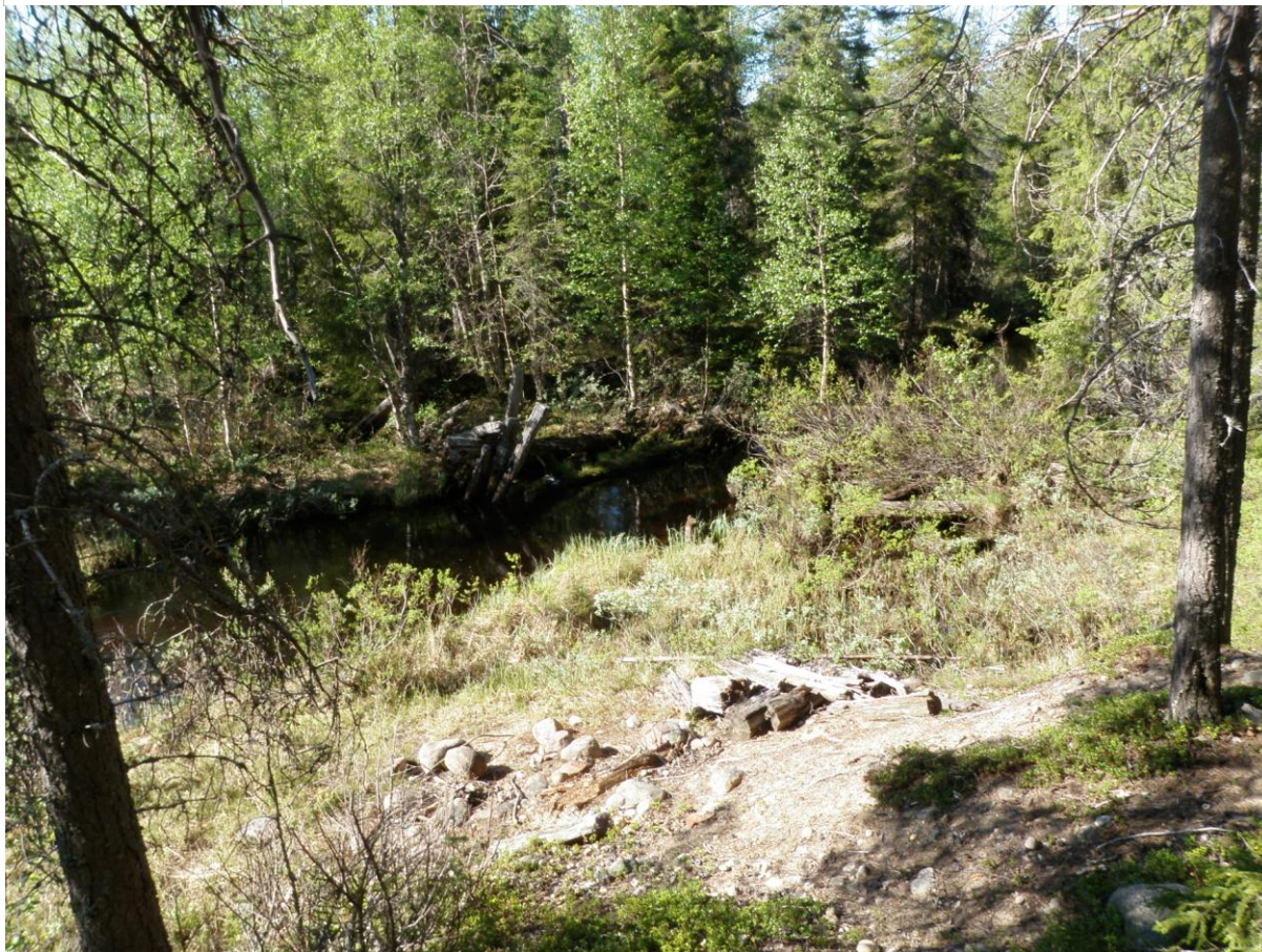
Uittopadon puurakenteita ojan takana, etualalla padon moreenipenkkää.
