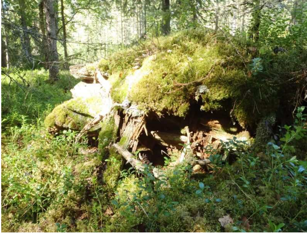
Yksityiskohtakuva itäpuolen seinälinjan hirsirakenteista.
