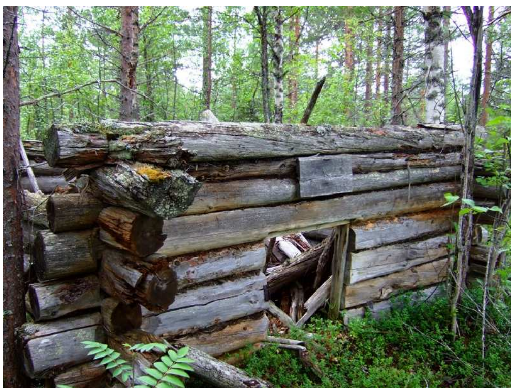
Kivijärvensuo rakennus jäännös.
