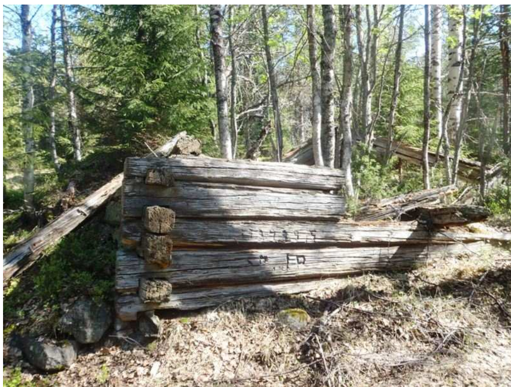
Päärakennus, jonka ulkoseinässä kaiverrusta.
