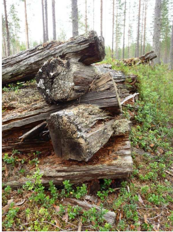
Yksityiskohtakuva tervapirtin nurkkasalvoksesta.
