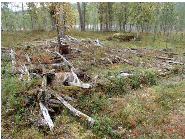
Kämpästä 3 on jäljellä lähinnä kattorakenteita, kuvattu etelään.
