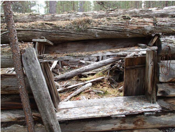
Rakennuksen 2 ikkuna kuvattuna kaakkoon.
