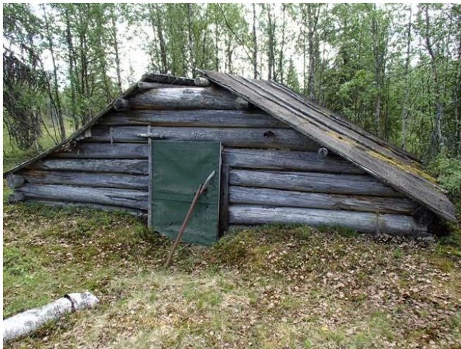
Yleiskuva ulkoa, kuvattu kaakkoon.
