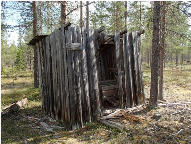
Käymälä 1, käymälät ovat ainoat yhä pystyssä olevat rakennelmat, kuvattu itään.
