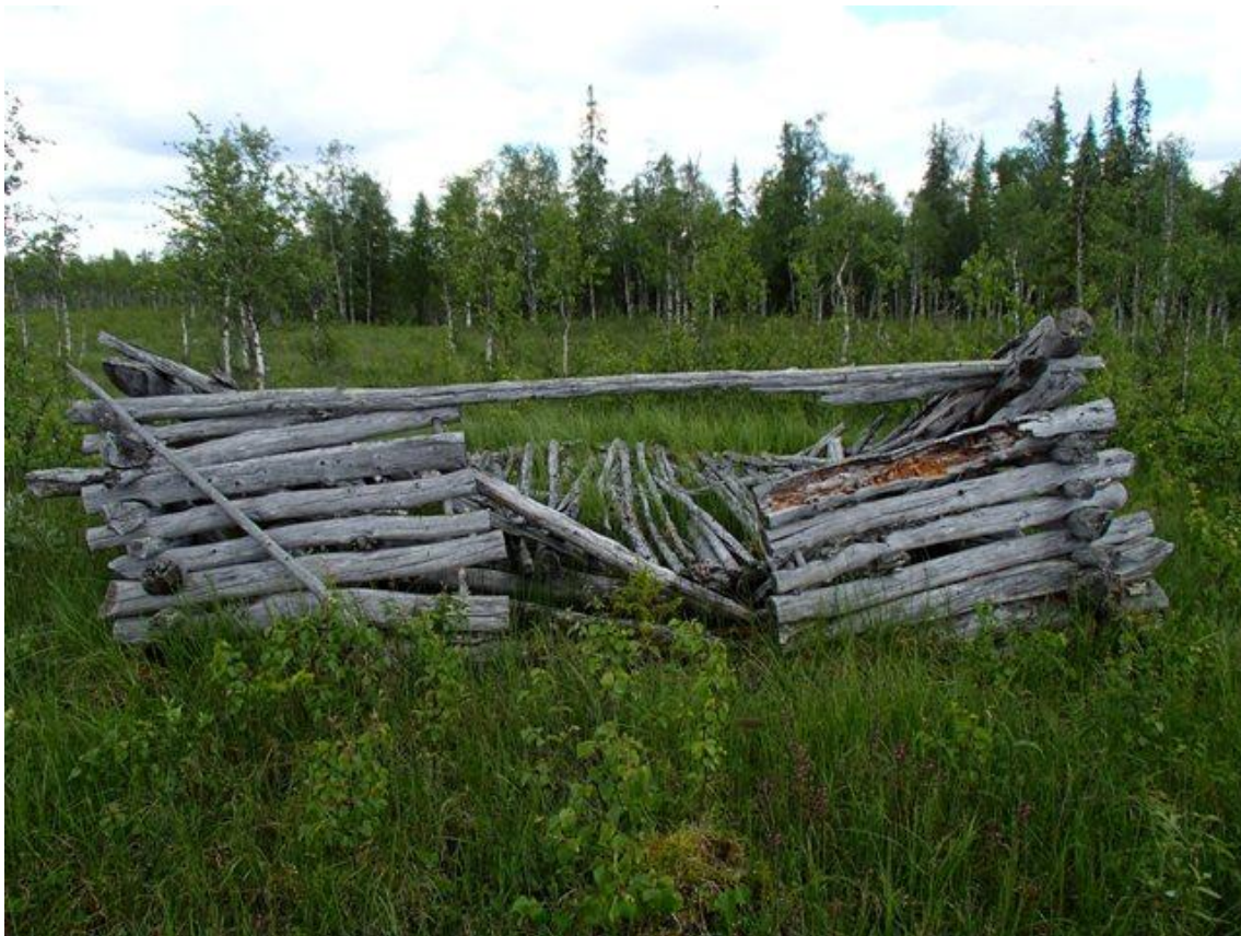
Yleiskuva ladosta, oviaukosta näkyvissä kattopuita, jotka ovat olleet katettu päreillä, kuvattu koilliseen.
