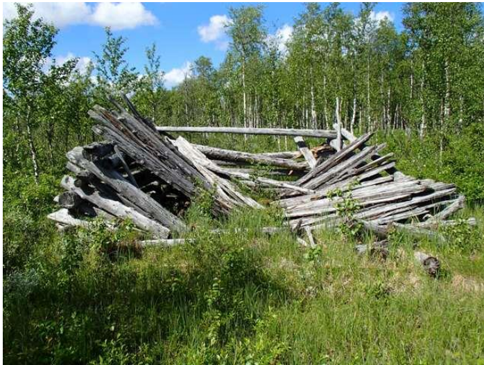
Ladon katto on tehty lohkotuista lankuista, kuvattu luoteeseen.
