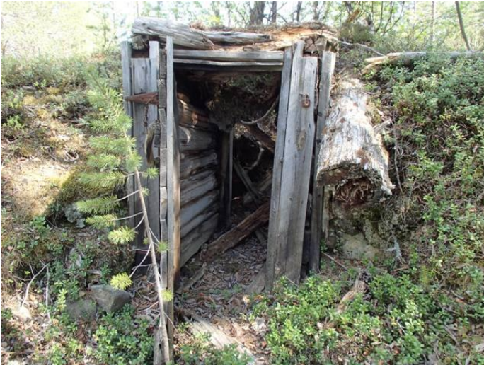
Kellarin oviaukko törmän reunalla, kuvattu koilliseen.
