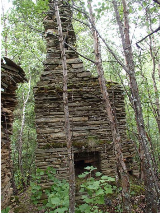
Liuskekivistä valmistettu piisi, vasemmassa reunassa näkyvän toisen piisin piippu on alkanut sortua, kuvattu länteen.
