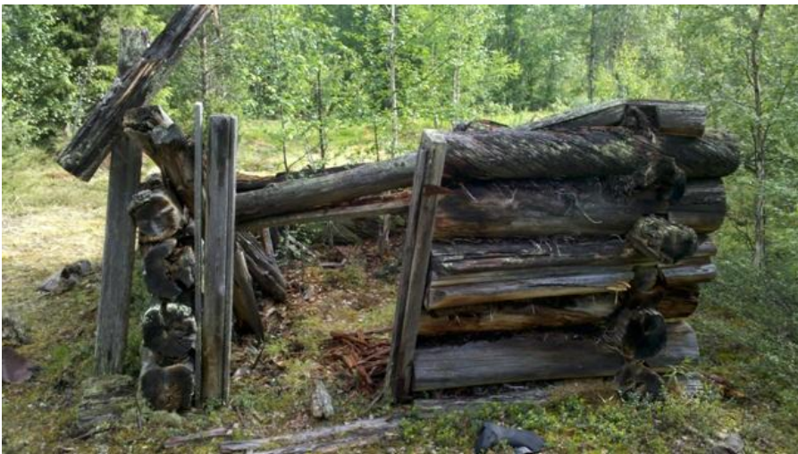
Varsin hyvin säilynyt pienen hirsirakennuksen jäännös, kuvattu koilliseen.
