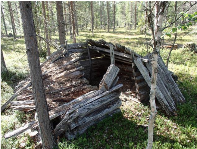
Laukon katto on osittain sortunut, ovi on nostettu oviaukon viereen, kuvattu etelään.
