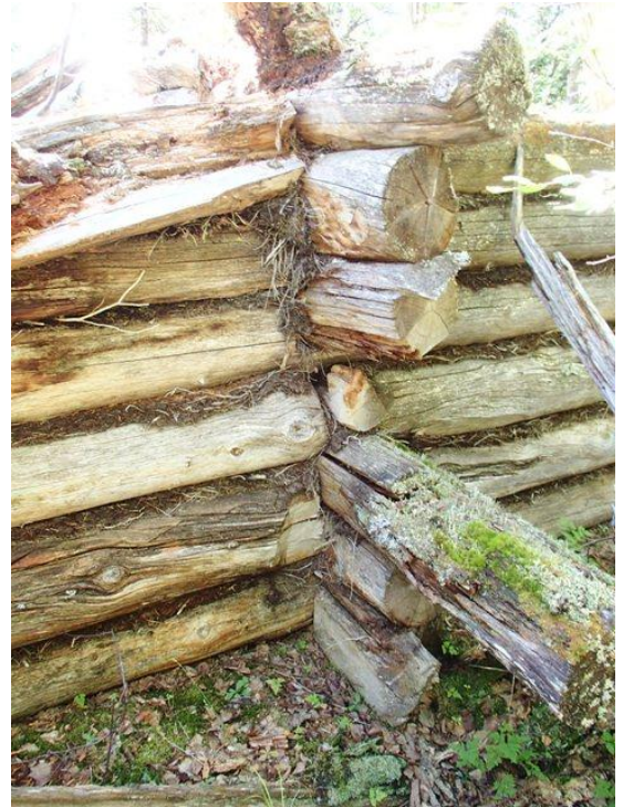
Kämpä 2, luoteispään väliseinän nurkkasalvos, kuvattu etelään.
