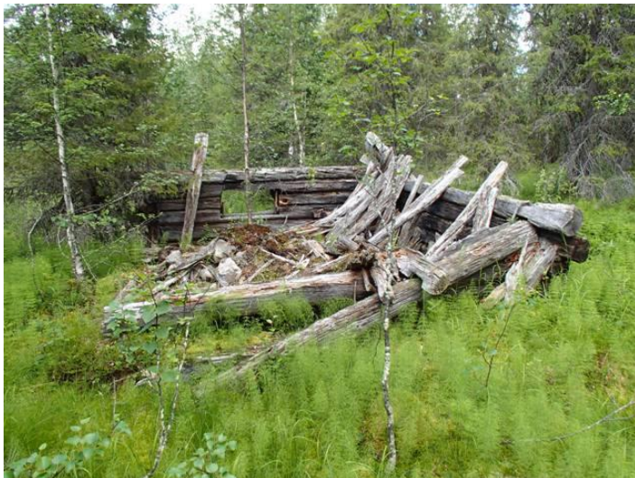
Mahdollinen saunan jäännös kuvattuna luoteeseen.
