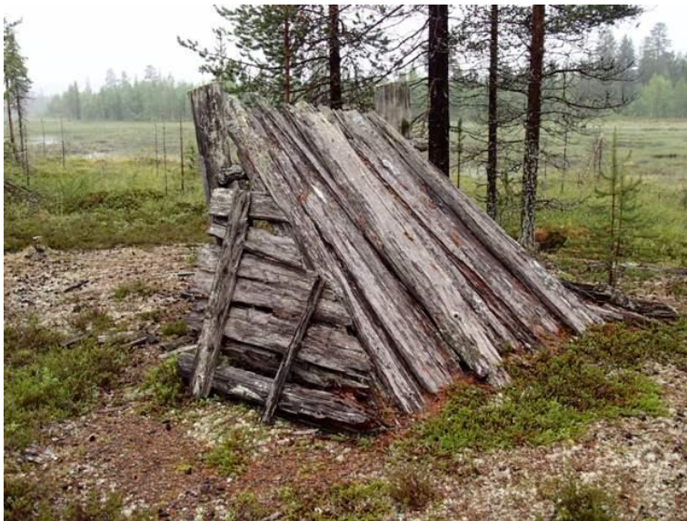
Katto ja seinät ovat lohkottuja lankkuja, kuvattu etelään.
