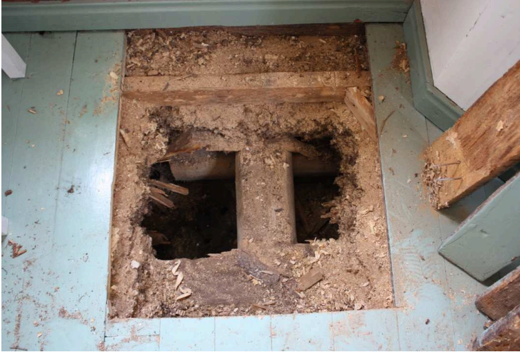
Kuva 12. Kaivaminen oli koekuoppa B:n kohdalla haastavaa suuren etäisyyden lattiataason ja alla olevan maapinnan vuoksi, kuvattu kaakosta. AKDG 3909:11
