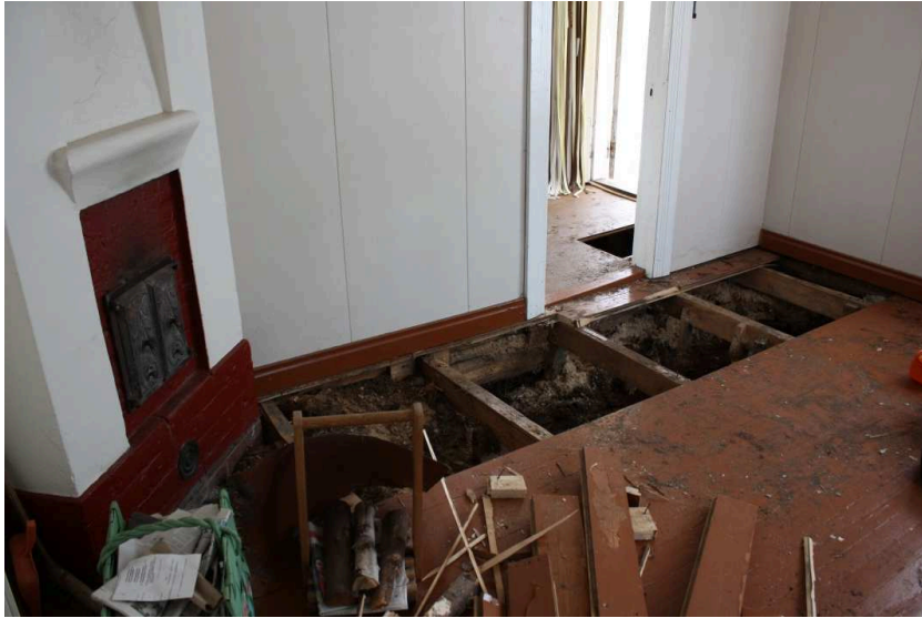
Kuva 7. Lattia on purettu koekuoppa A:n kohdalla, taustalla näkyy viereisessä huoneessa koekuoppa C, kuvattu luoteesta. AKDG 3909:6
