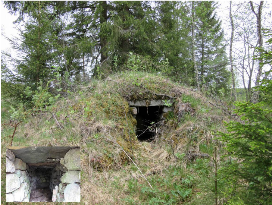
Rakenne 3, luonnonkivistä tehty kellari ja kuva sisältä.
