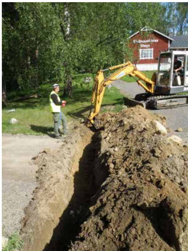
Kuva 6. Koejoja 1 avataan kaivinkoneella. Kuva GH.
