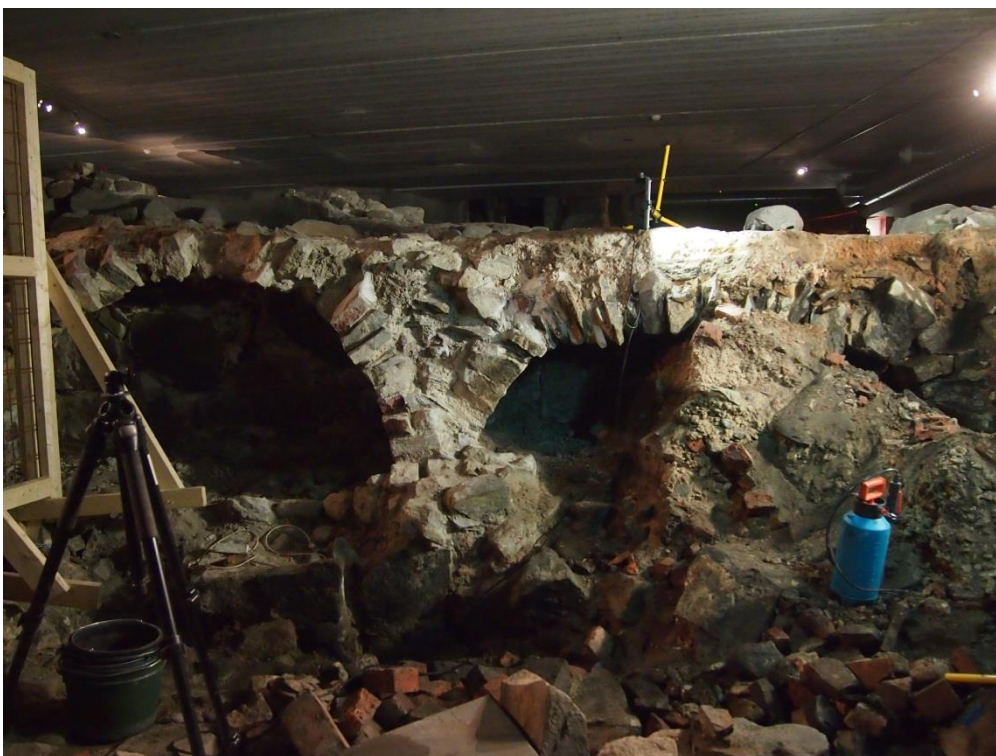
Kuva 13. Holvikomerot R23:1 (vasemmalla) ja R23:2 lounaaseen konservoinnin aikana lokakuussa 2014. Ilari Aalto.
