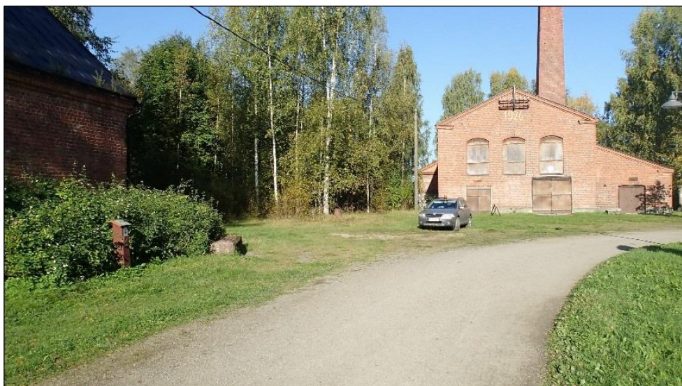
Maakaapelilinjan aluetta ennen kaivamista. Maakaapelilinjan reitti on hiekkatien vasemmalla puolella ilmalinjan kohdalla päättyen tiilirakennuksen kulmalle. kuvattu luoteeseen.
