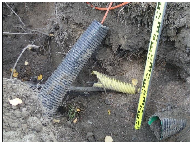
Vanha höyryputki ja vanhoja sähkökaapeleita maakaapelikaivannossa.
