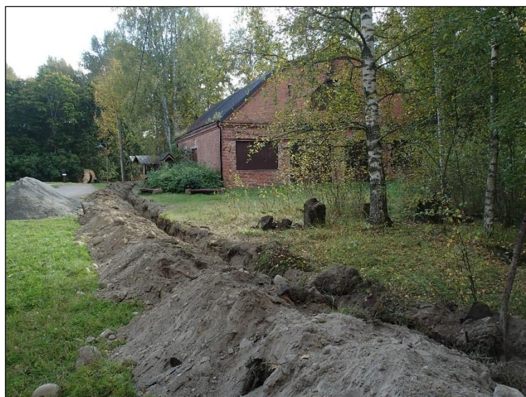
Arkeologisessa valvonnassa kaivettua maakaapelilinjaa kahden vanhan tiilirakennuksen välisellä alueella. Kuvattu etelään.
