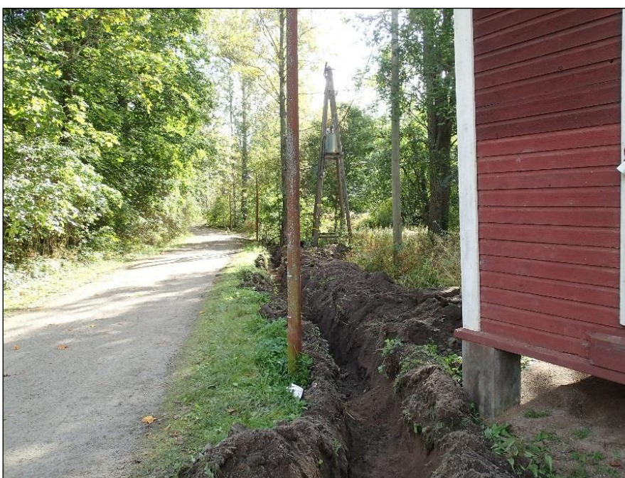
Arkeologisessa valvonnassa kaivettua maakaapelilinjaa. Kuvattu etelään.
