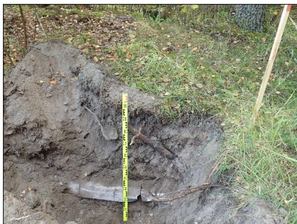
Vanha höyryputki ja vanhoja sähkökaapeleita maakaapelikaivannossa.
