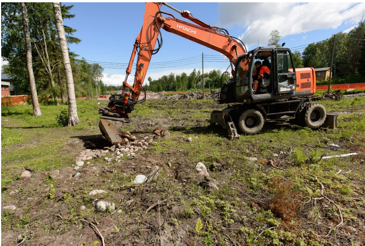
Kuva 3. Tykkitiehen tehdään poikkileikkausta kaivinkoneella. Kuva lounaasta. (AKDG4229:17)
