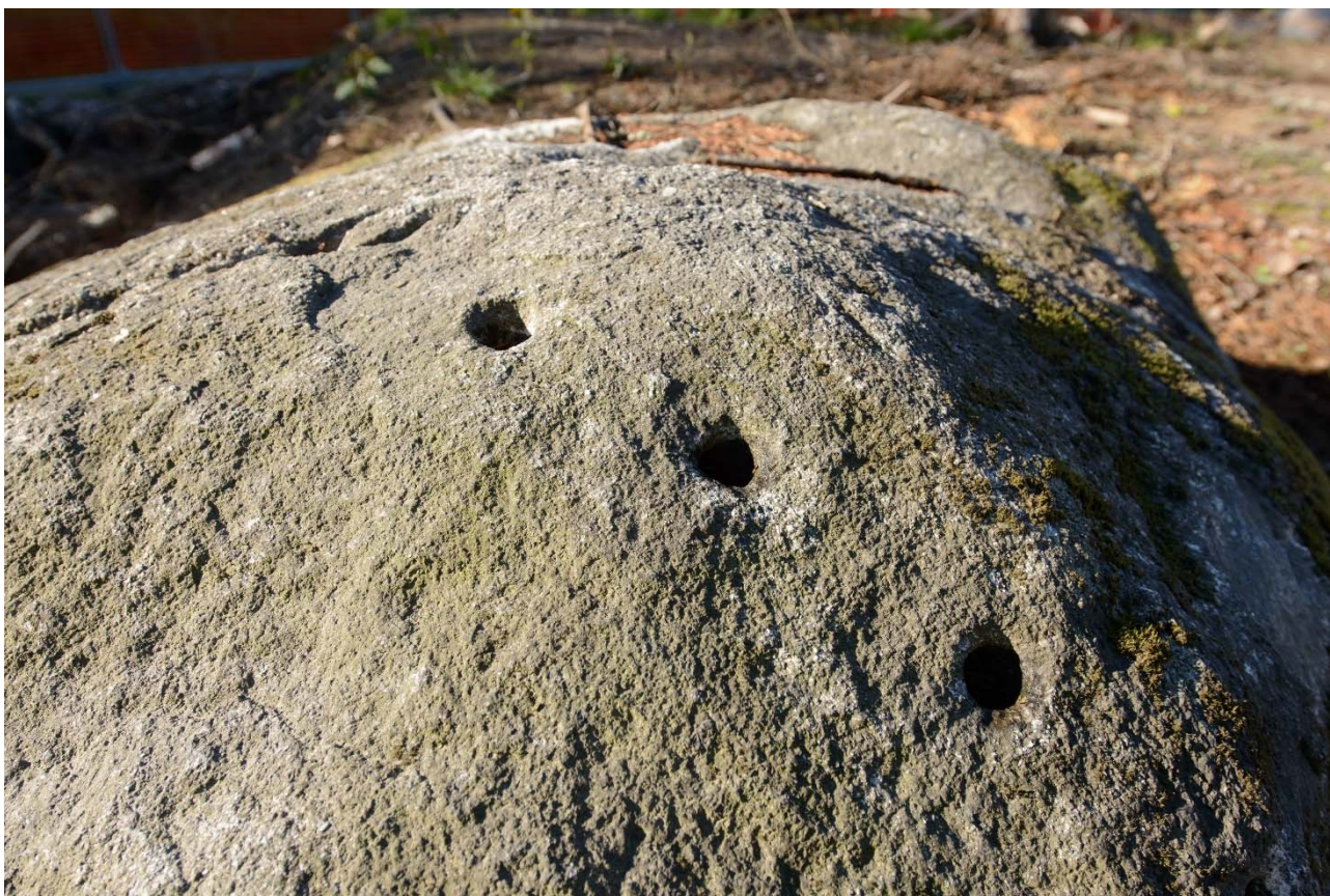
Kuva 12. Isossa kivessä olevat räjäytysreiät. (AKDG4229:6)
