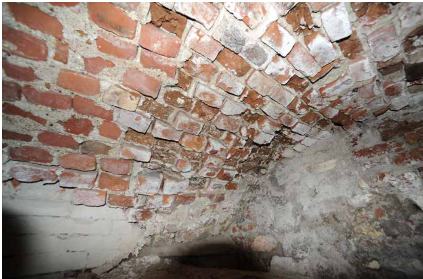
Kuva 18. Kellari 016 suurtorin puoleinen korjattu seinäosa.
