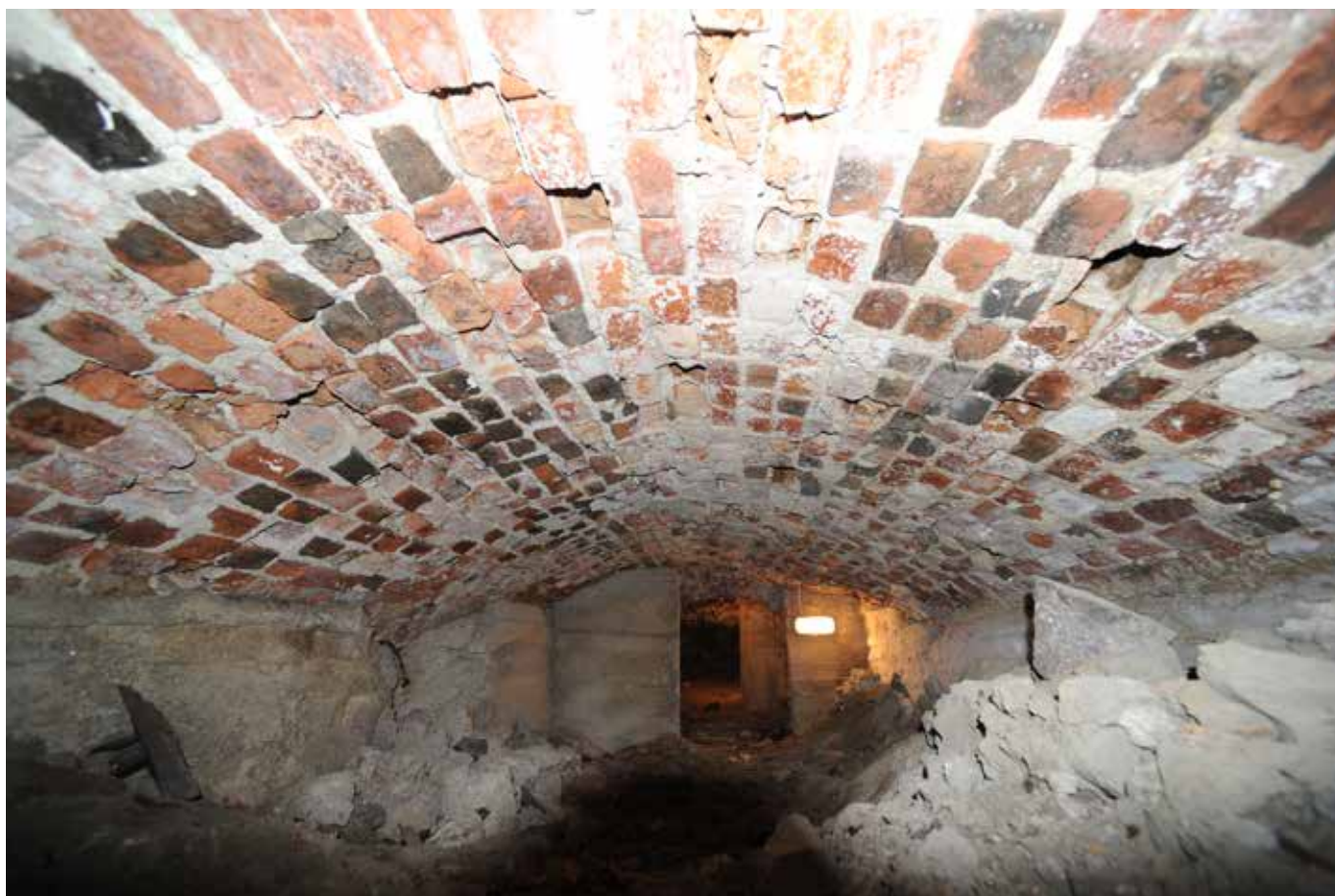
Kuva 21. Kellari 017 kohti kellaritilaa 015.
