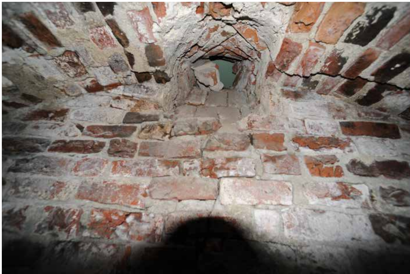
Kuva 22. Kellari 017 ikkuna-aukko päätyseinässä.
