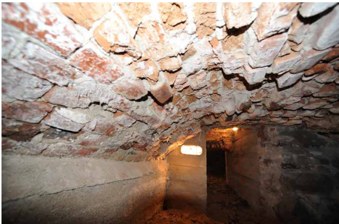
Kuva 19. Kellari 016 kohti kellaritilaa 015.
